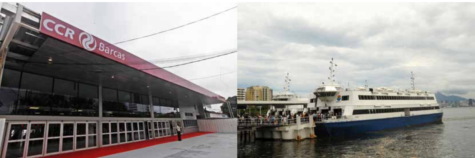
Fig. 4.79 CCR Barcas Praça Araribóia Terminal and a CCR Barcas Catamaran. http://imageshack.com/f/mubkmuj http://imagem.band.com.br/f_270764.jpg
