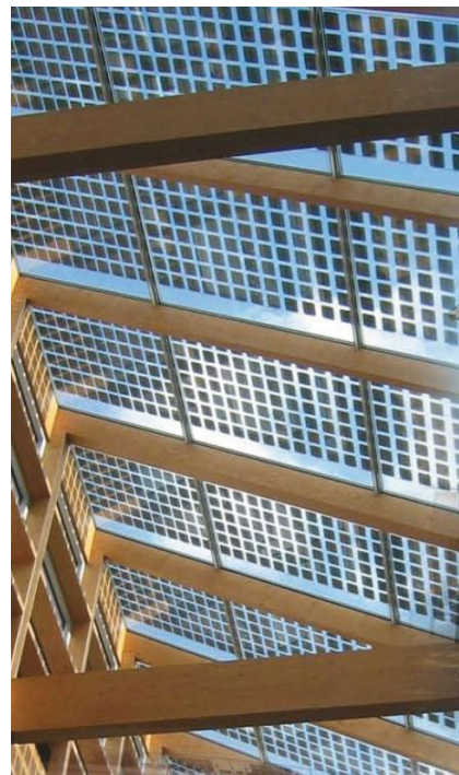
figura XII.520: Pannelli fotovoltaici semitrasparenti [Fonte: talev.fr]
