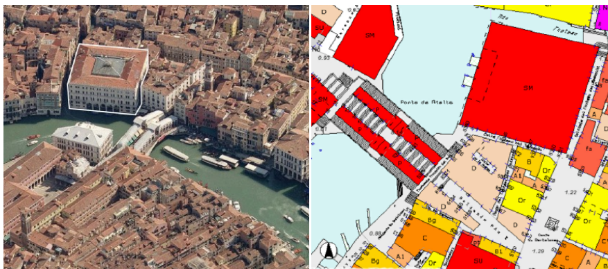
Fig.10 - Cantiere a Venezia con evidenti difficoltà di accesso all'area
