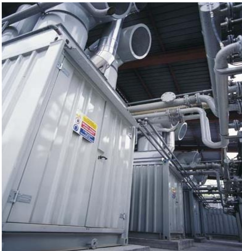
Figura 13 - Impianto biogas ECONORD
