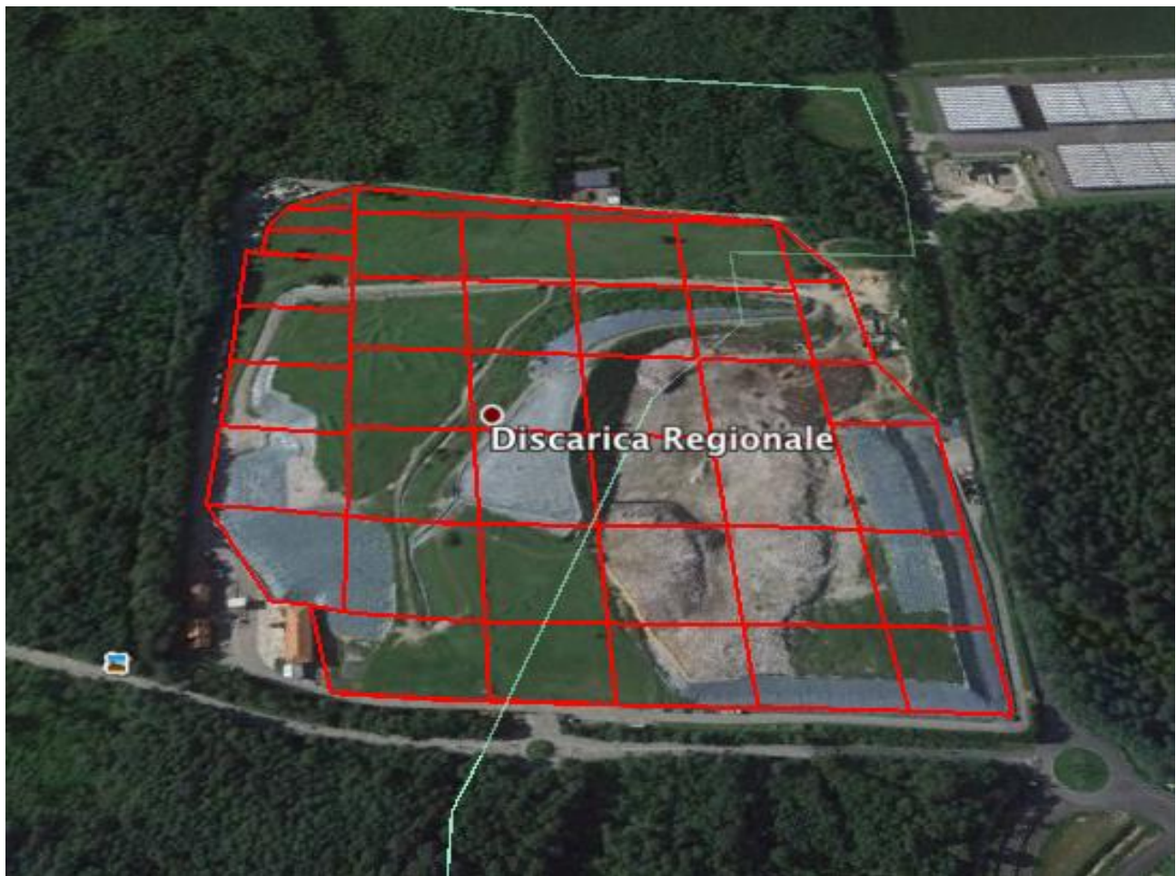
Figura 15 - Una veduta della discarica suddivisa in celle
