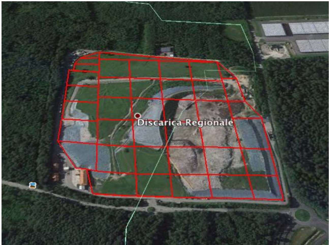
Figura 15 - Una veduta della discarica suddivisa in celle
