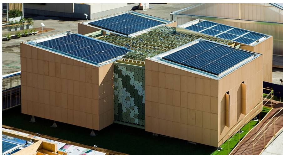
Fig. 16 – Patio 2.12, vista dei prospetti sud e ovest. 17
