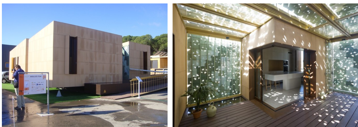
Fig. 43 – A sinistra: effetto evaporativo della facciata e vasca esterna 36 . A destra: vista dall’interno del patio con la vasca interna e delle lamelle mobili, Patio 2.12, Team Andalusia. 37
