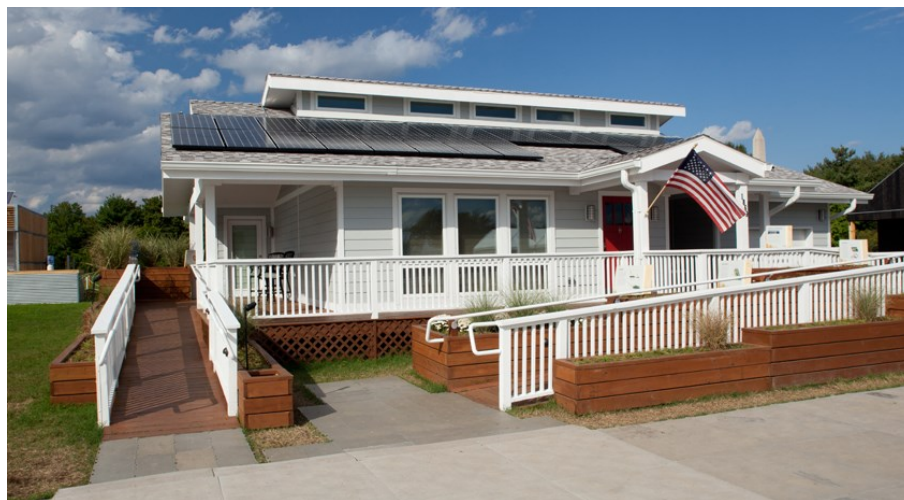
Fig. 12 – INhome, vista del prospetto sud. 14
