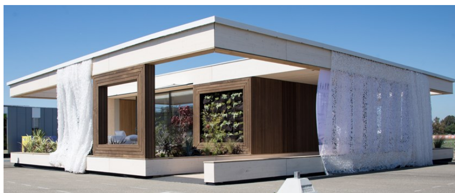
Fig. 18 – Lisi, vista dei prospetti sud ed est 18
