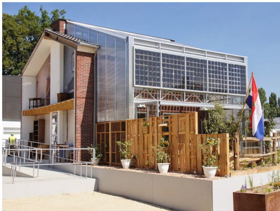
Fig. 24 – Prêt à Loger, vista dei prospetti sud ed est. 21
