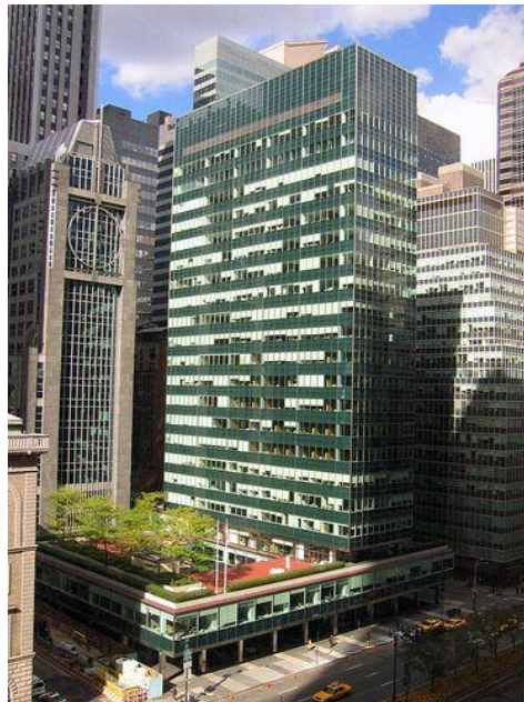
Figure 4: Lever Building, 1951-52, studio di architettura SOM
