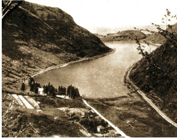
Vista Aerea del Lago
