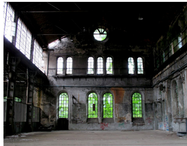
Interno prima della riqualificazione
