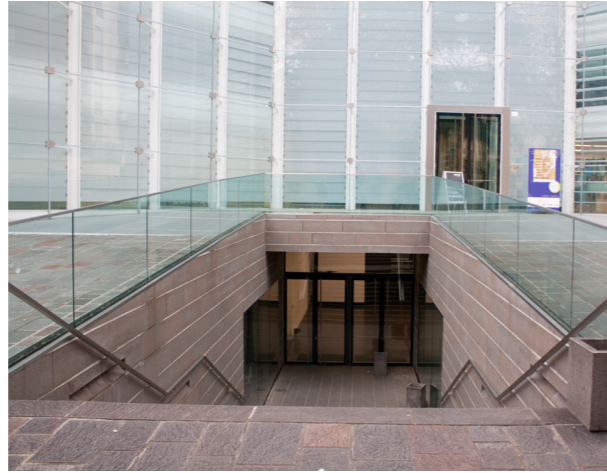
Ingresso per l'interrato
