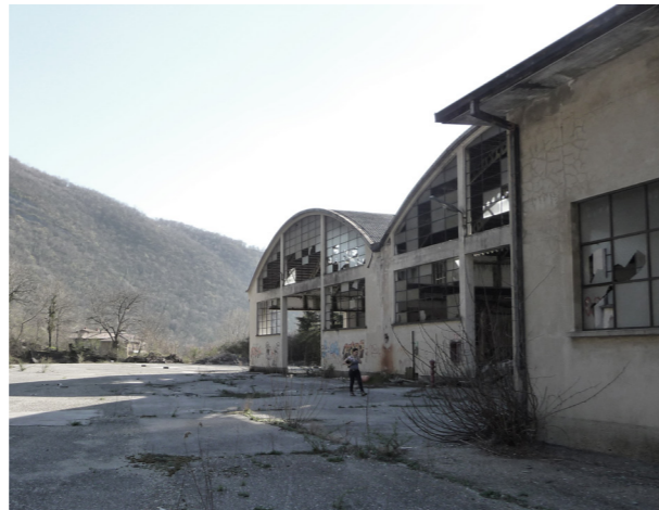
Facciata sul retro
