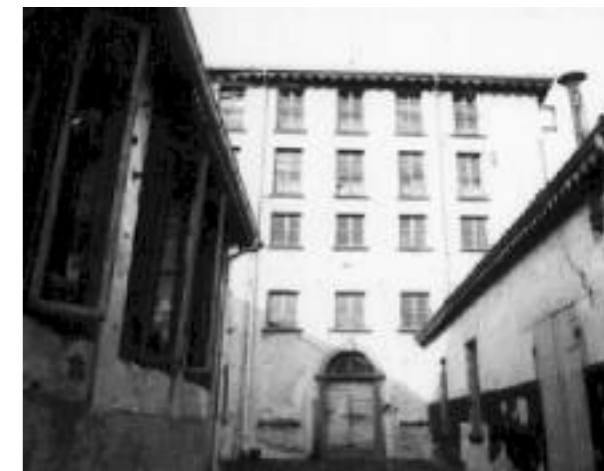
Filatoio dell'Oro o della Torre, Ello
