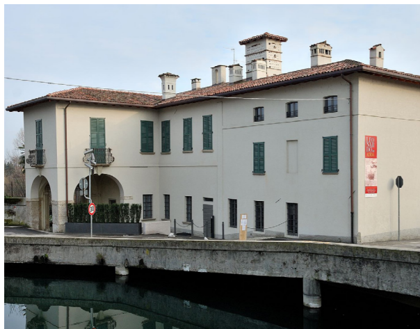
Casa del Custode delle Acque
