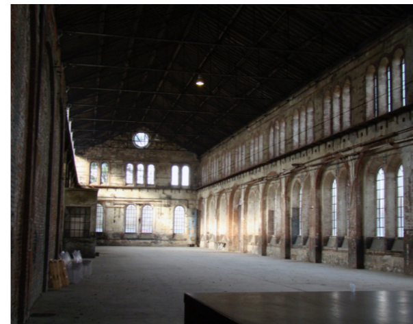
Interno prima della riqualificazione
