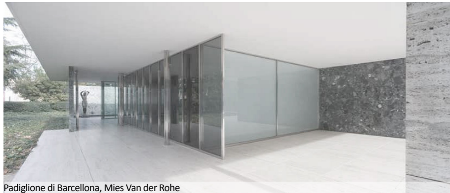
Padiglione di Barcellona, Mies Van der Rohe
