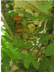
Dettaglio sulla muratura
