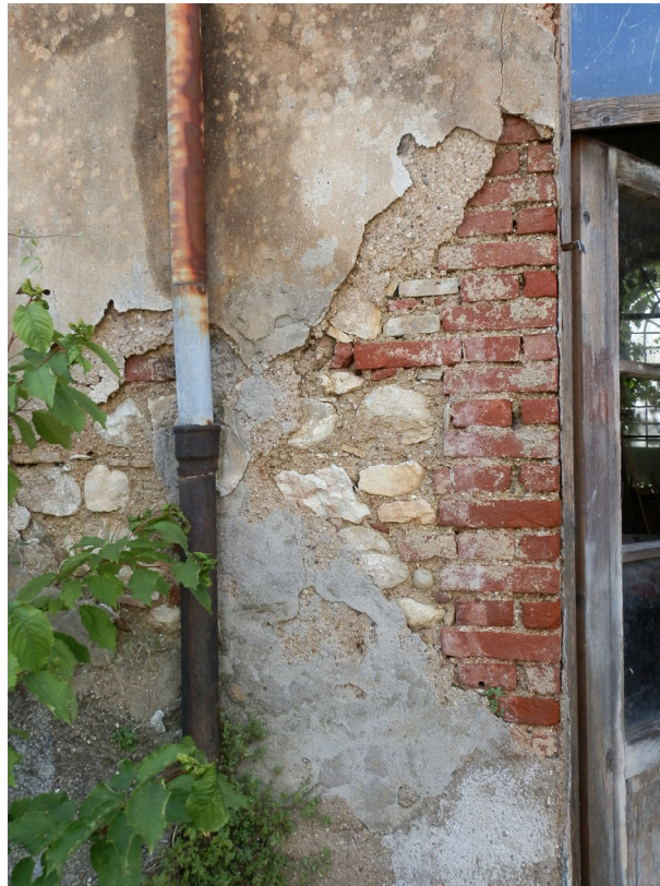
Figura 17 – Dettaglio sullo stato attuale della muratura
