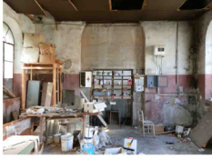
Interno piano terra
