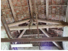
Dettaglio sulla copertura
