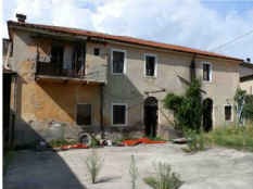
Corpo di fabbrica parallelo alla strada
