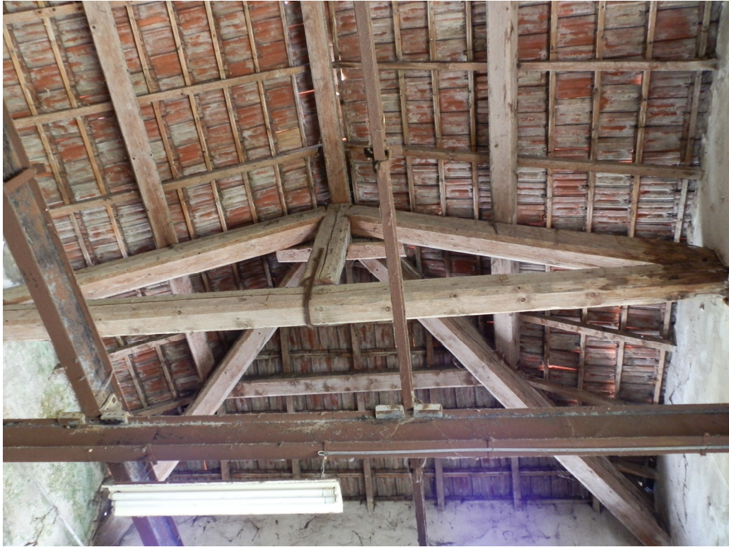
Figura 16 – Vista del tetto interno
