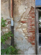
Dettaglio sulla muratura
