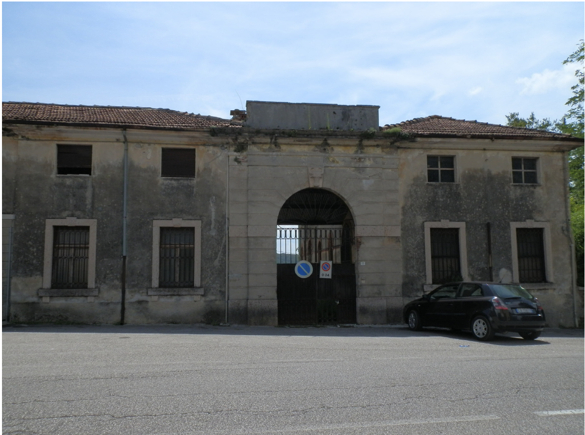
Figura 11 – Ingresso attuale dell'edificio
