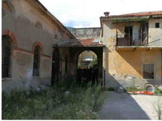
Interno visto dal giardino interno
