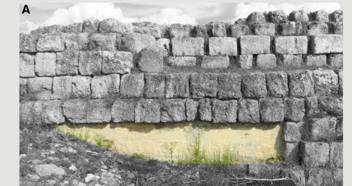
INTEGRAZIONE AD OVEST CON UNA MURATURA IN MALTA CEMENTIZIA
