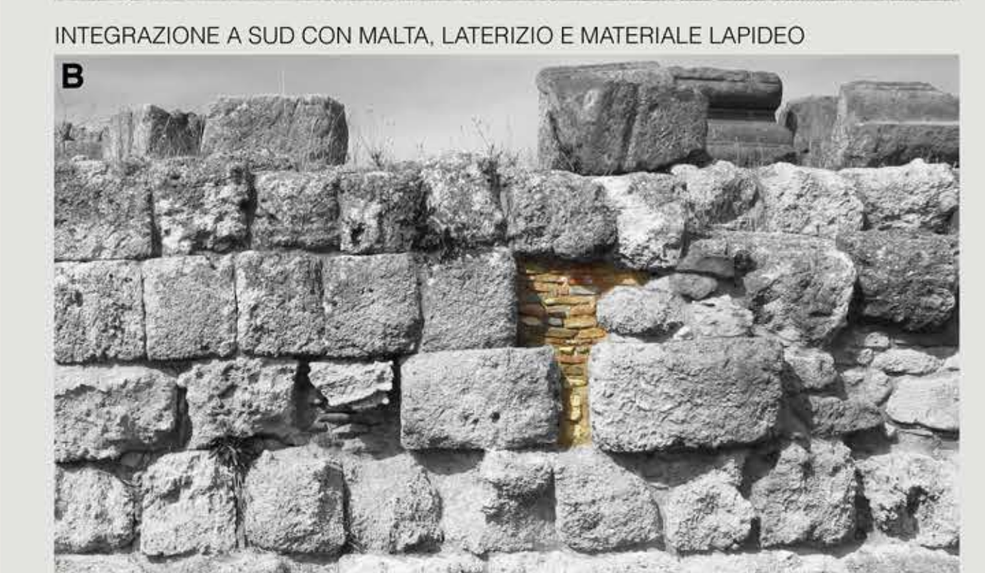
INTEGRAZIONE A SUD CON MALTA, LATERIZIO E MATERIALE LAPIDEO
