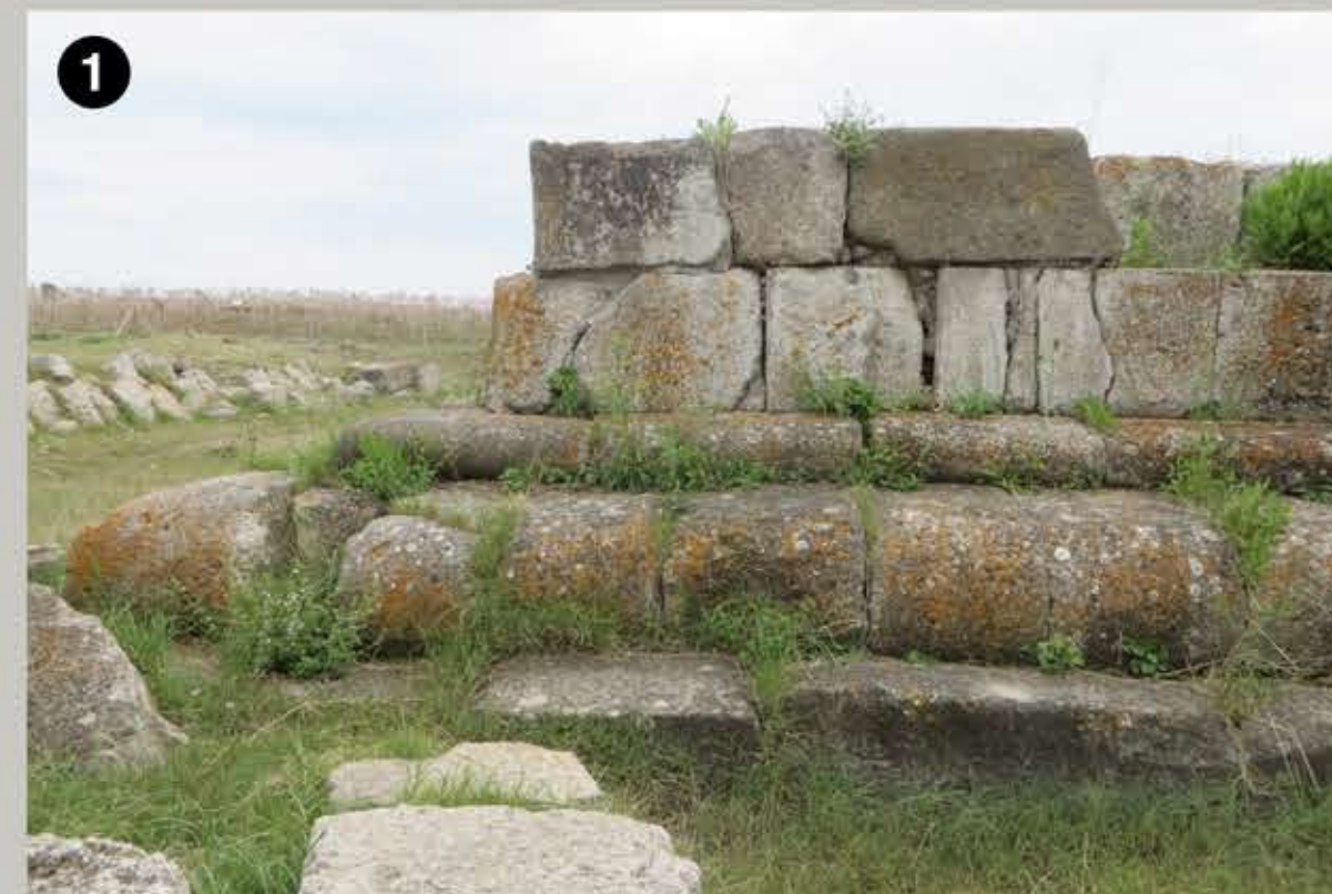
COLONIZZAZIONE BIOLOGICA PRESENTE NEL PROSPETTO NORD
