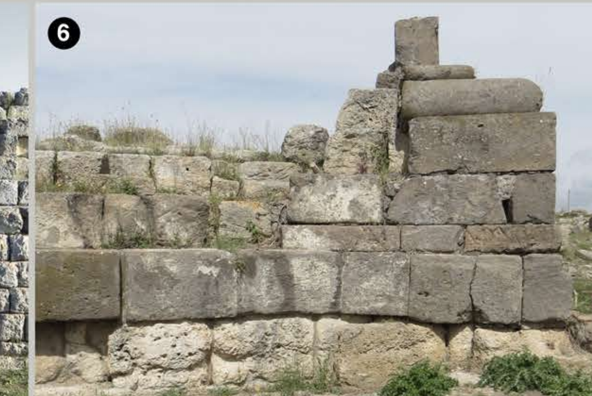
A SUD ALCUNI BLOCCHI IN MACCO SONO FORTEMENTE DISGREGATI
