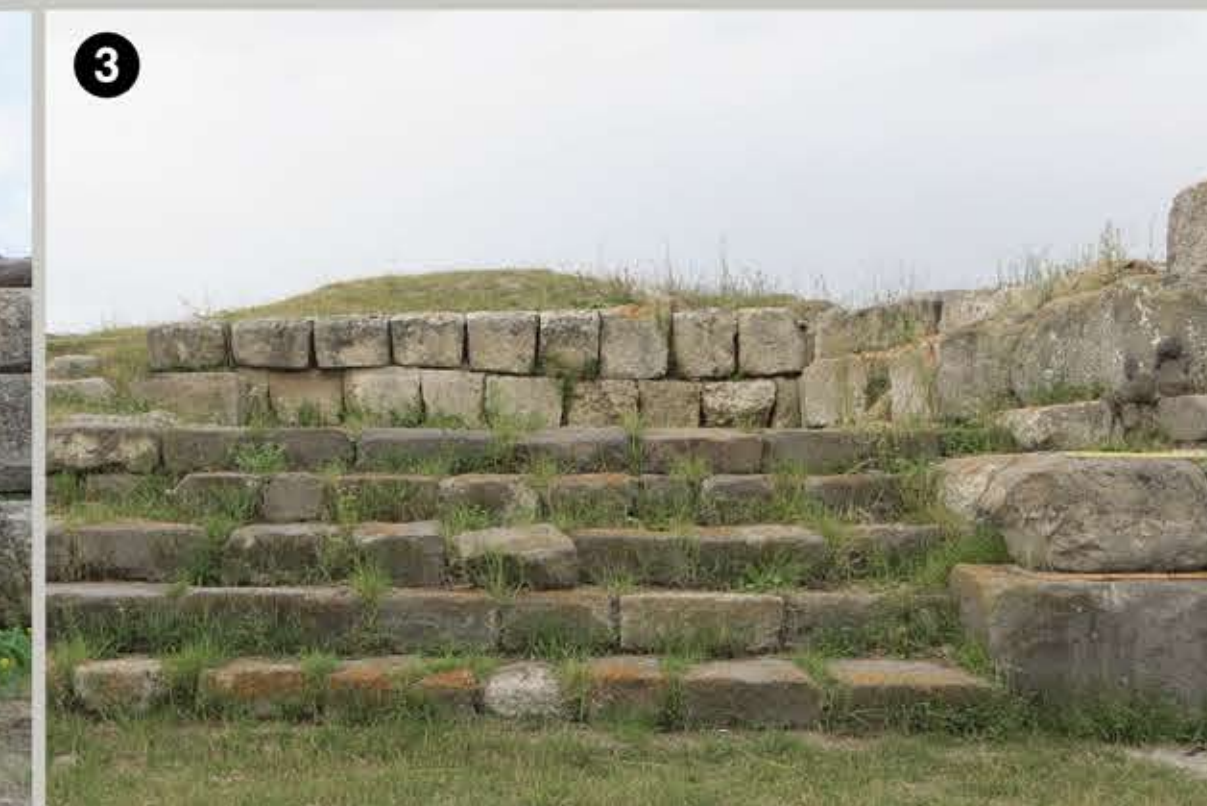
COLONIZZAZIONE BIOLOGICA PRESENTE NEL PROSPETTO EST
