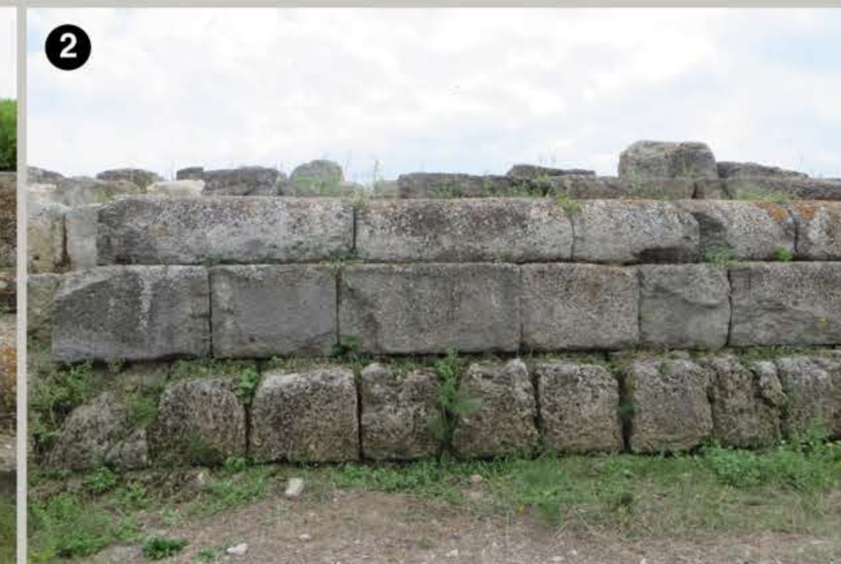
I BLOCCHI IN MACCO SONO PIU' EROSI RISPETTO A QUELLI IN NENFRÒ
