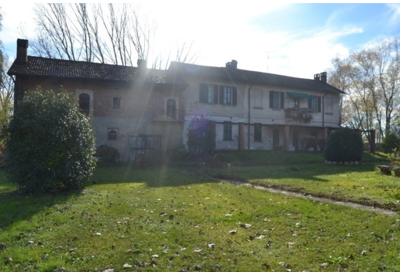
Fig. 29_Cascina Poscallone. Edificio residenziale e del '400.
