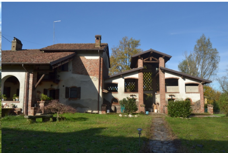
Fig. 30_Cascina Poscallone. Edificio ex porcilaia.
