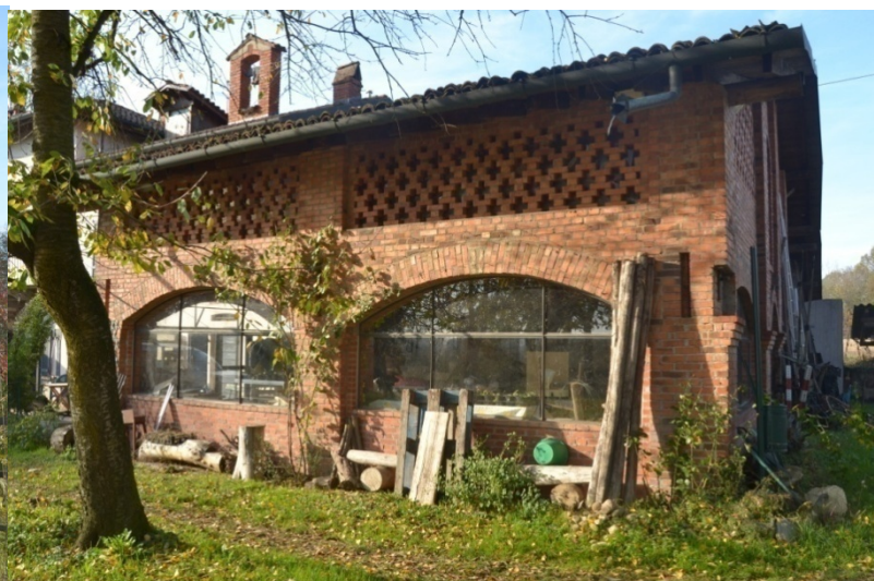
Fig. 25_Cascina Agosti. Edificio per ricovero di attrezzi.
