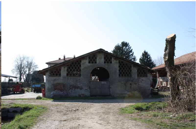
Fig. 20_Cascina Gambarina. Edificio ex porcilaia.
