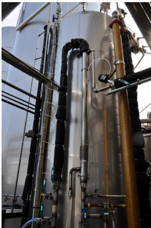
Figura 2.9 Reattore di Digestione Anaerobica B-03 con unità di UF esterna
