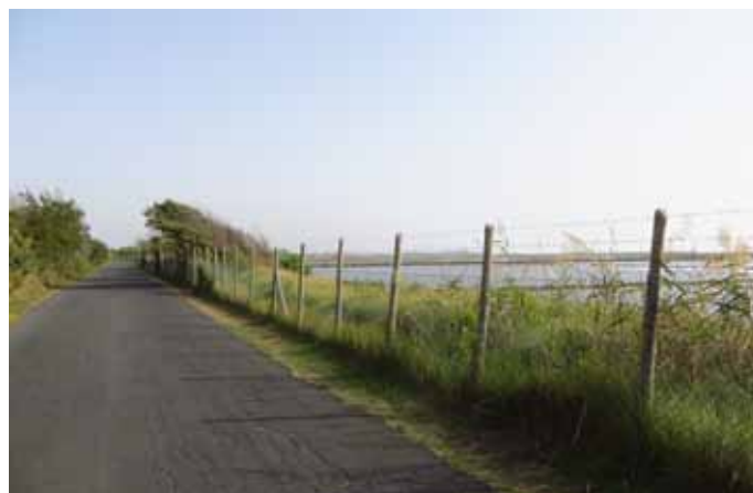
Fig.84 Vista del percorso lungo la strada di accesso alla Riserva delle Saline.
