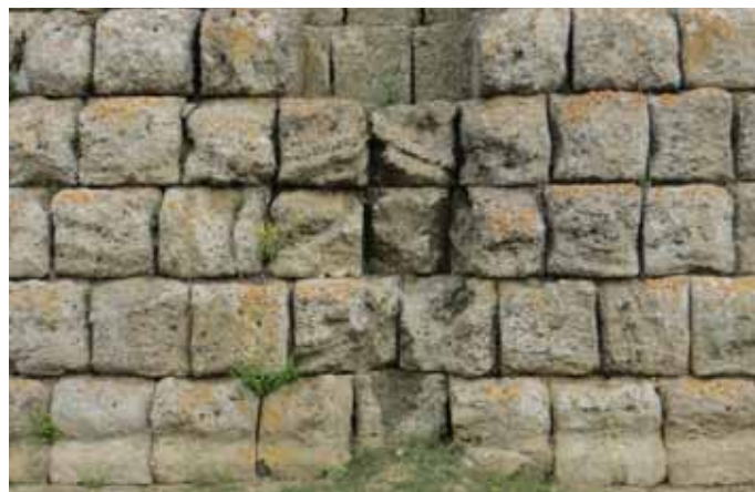
Fig.127 Il Macco è particolarmente eroso al centro della muratura meridionale a causa del ruscellamento delle acque.
