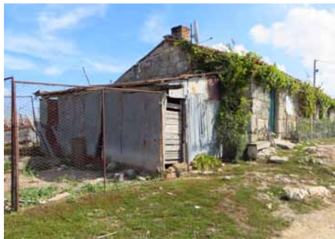
Fig.98 Aggiunte realizzate presso il casale degli scavi con materiali fatiscenti che deturpano il vecchio edificio.
