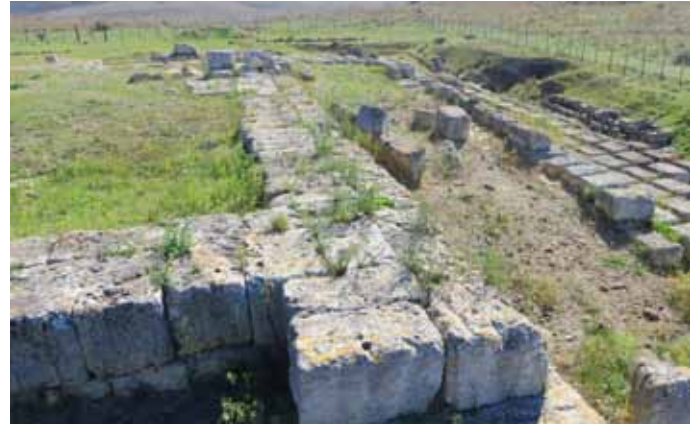
Fig.117 Gli alzati presenti in pianta sono quasi tutti realizzati in Macco.
