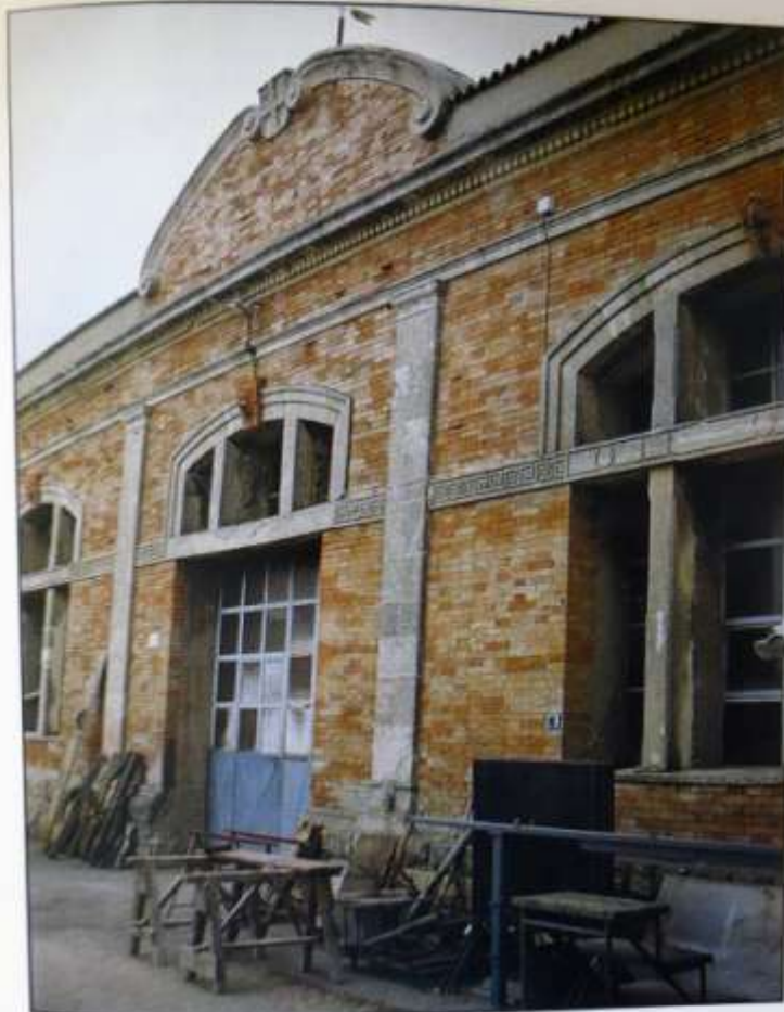
Fabbricato del 1917 per magazzini ed officine, prospetto principale (foto G. Mencarelli)
