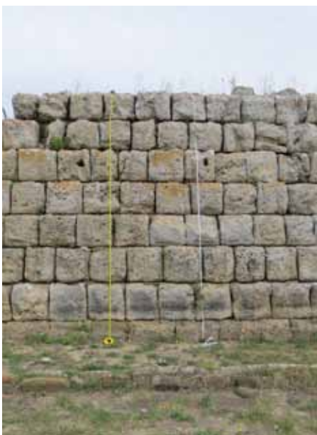
Fig.111 Prospetto sud, fotografia in situ con bindelle e metri rigidi.
