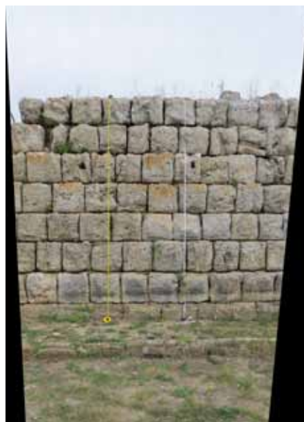
Fig.112 Fotografia raddrizzata con il software Perspective Rectifier 3.3.
