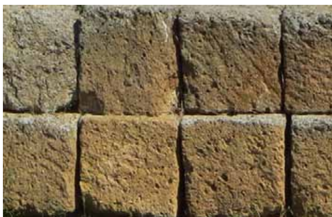
Fig.122 La presenza di Tufo rosso, roccia piroclastica, è estremamente limitata sul tempio.
