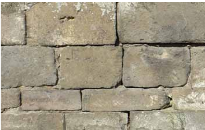
Fig.118 Il Nenfro, materiale utilizzato nell'ultima fase costruttiva del tempio, è una ignimbrite trachitica, pietra compatta.
