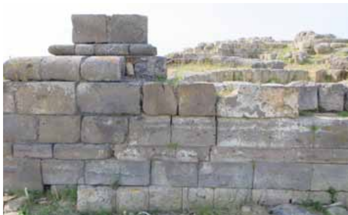
Fig.120 La muratura del prospetto ad est è realizzata quasi completamente in Nenfro.
