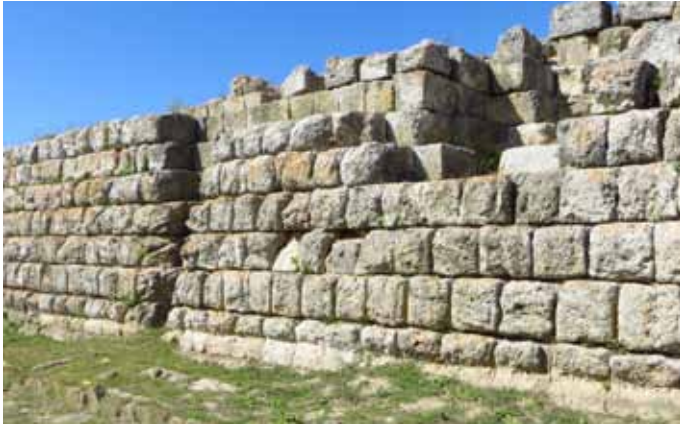
Fig.116 Gran parte della muratura meridionale è costruita in grandi blocchi in Macco disposti a secco, senza uso di malte.
