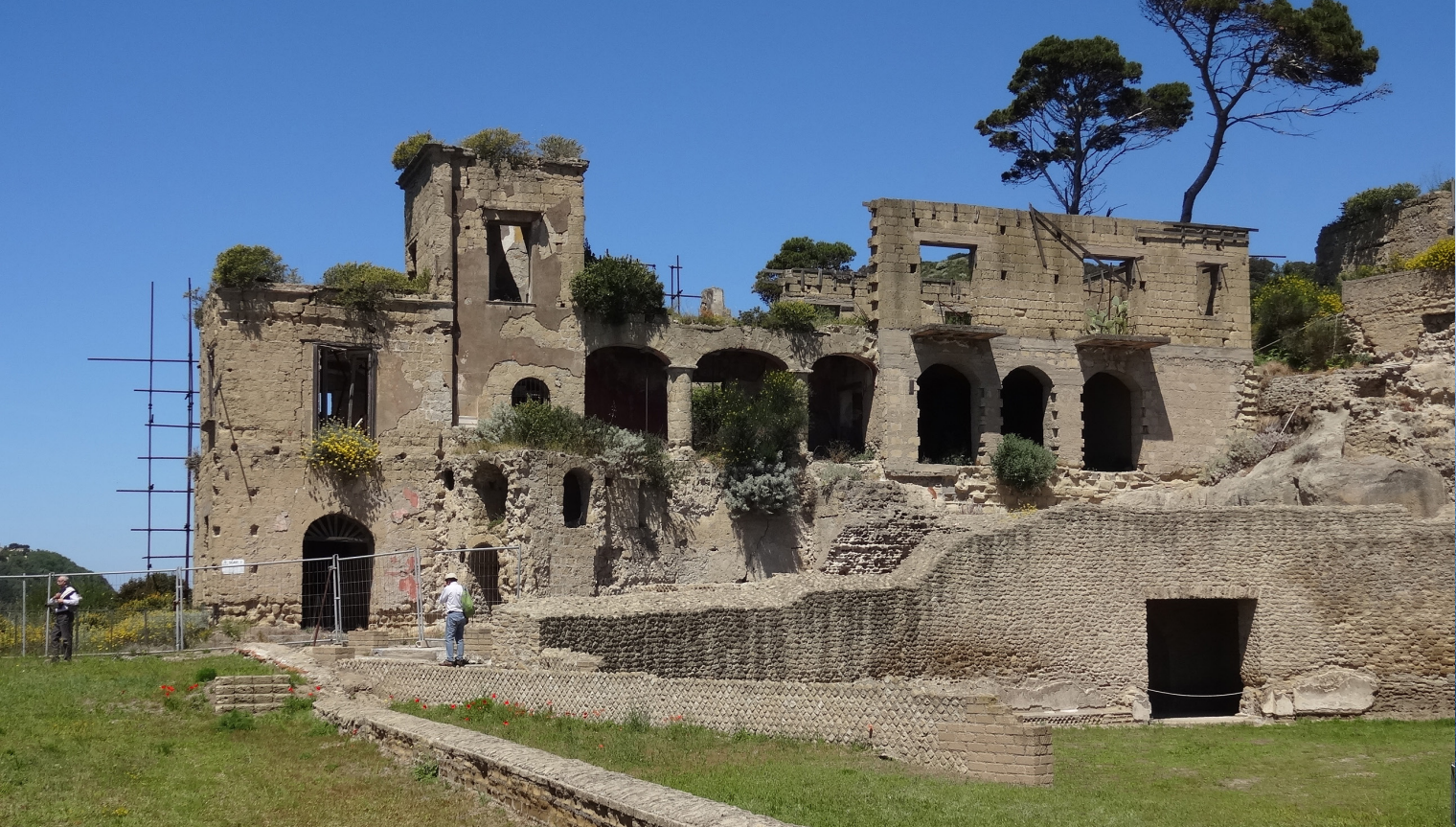
Vista della Casa Rossa _ Area pubblica della villa romana
