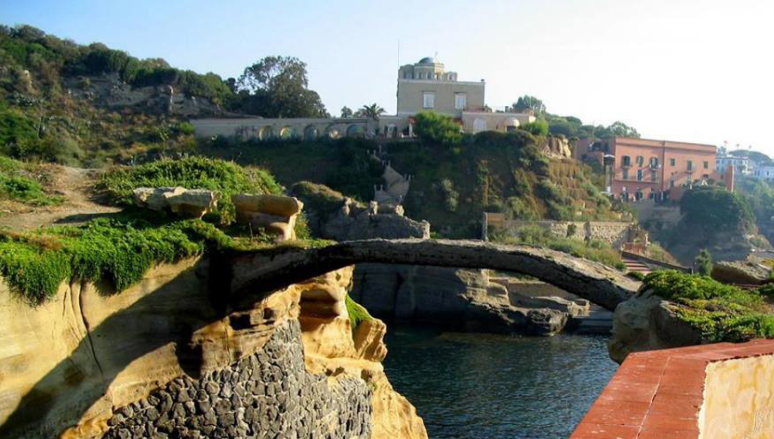
Vista del ponte della Gaiola
