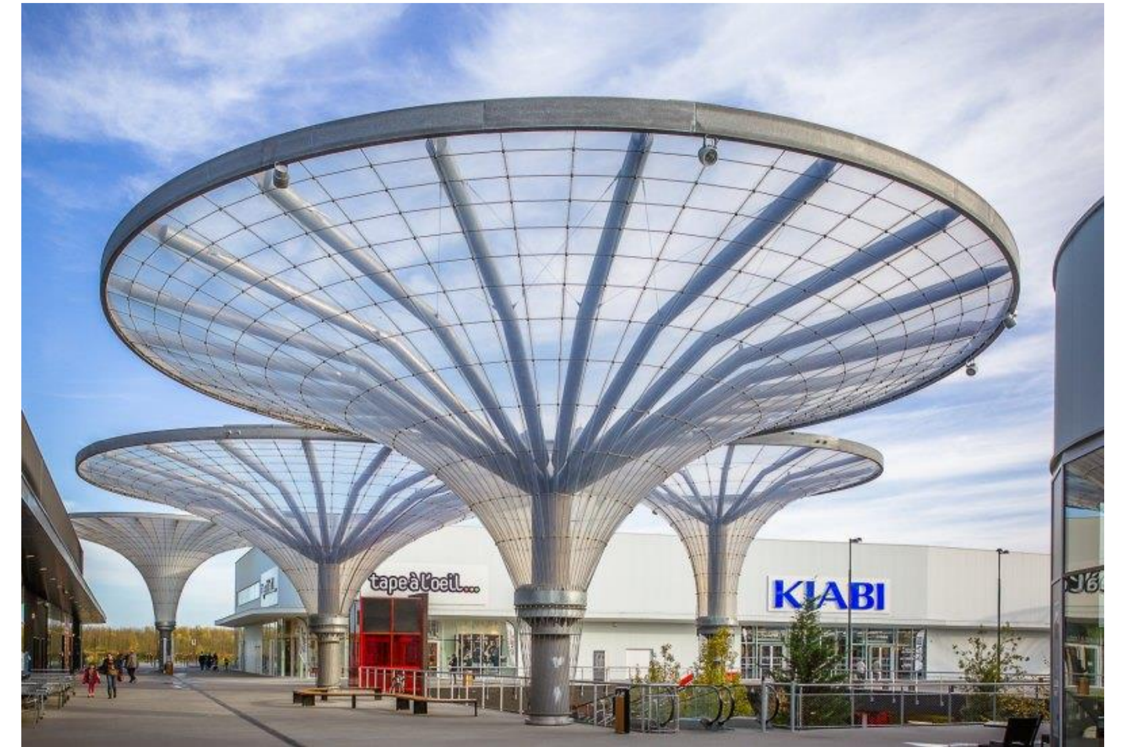
Figure 117) Parc des Vergers de la Plaine, Chambourcy, France, 2012
