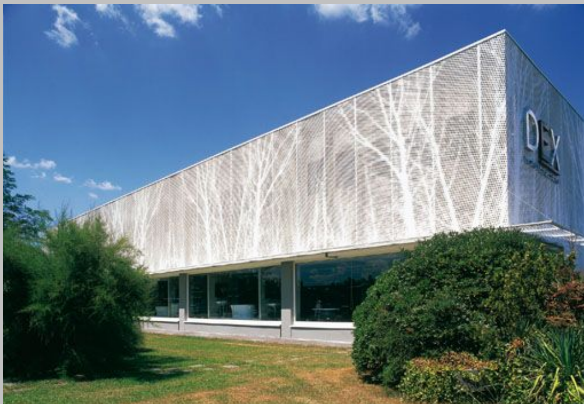
Illustrazione 7: Fotografia del corpo di fabbrica in oggetto
