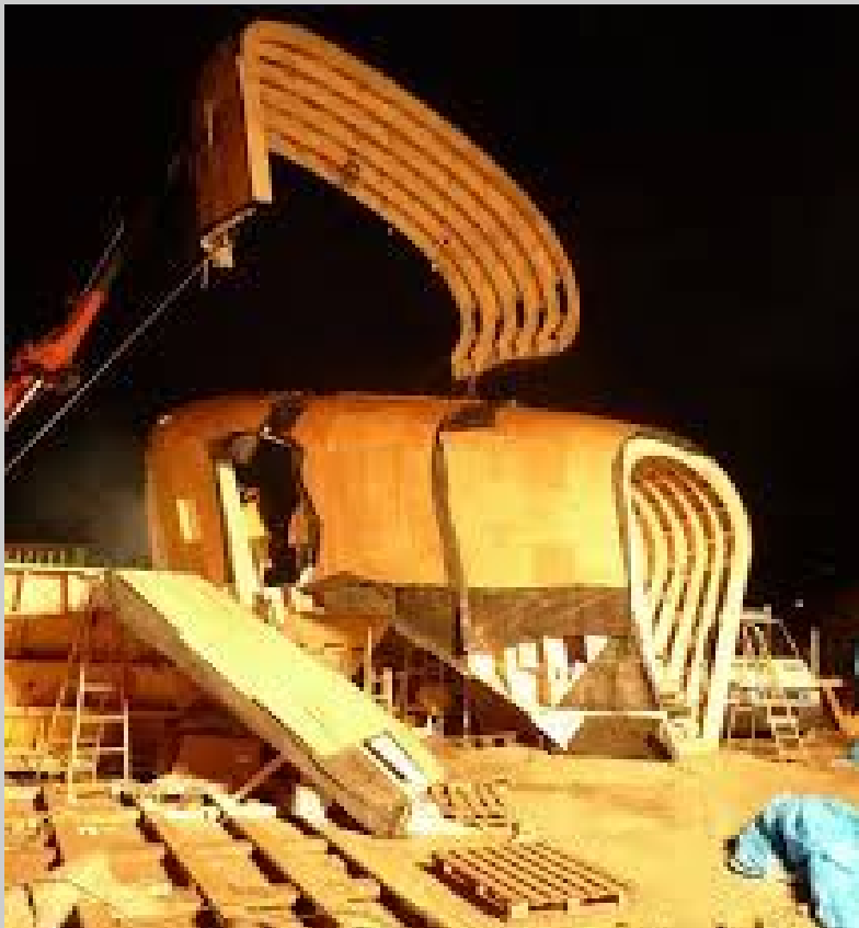
Illustrazione 35: assemblaggio tramite gru di una sezione
