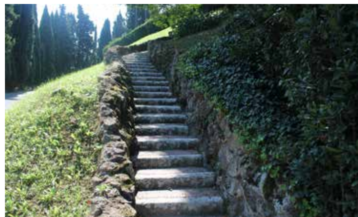
FIG.5 L'attuale scaletta di ingresso pedonale alla villa.
