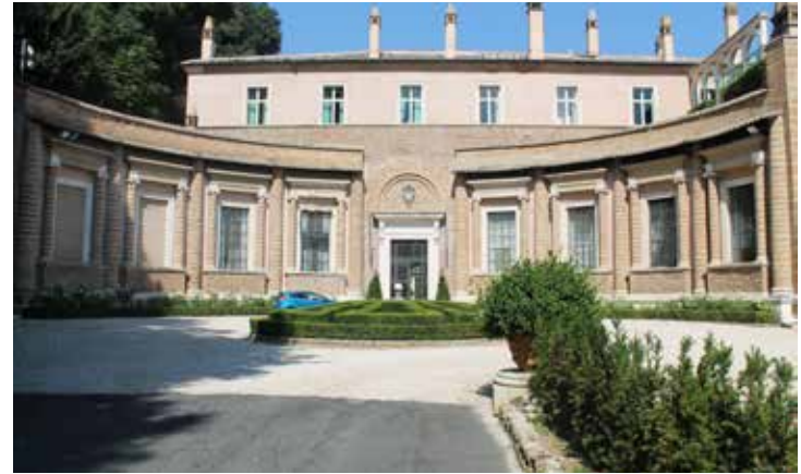
FIG.3 Esedra di ingresso alla villa.
