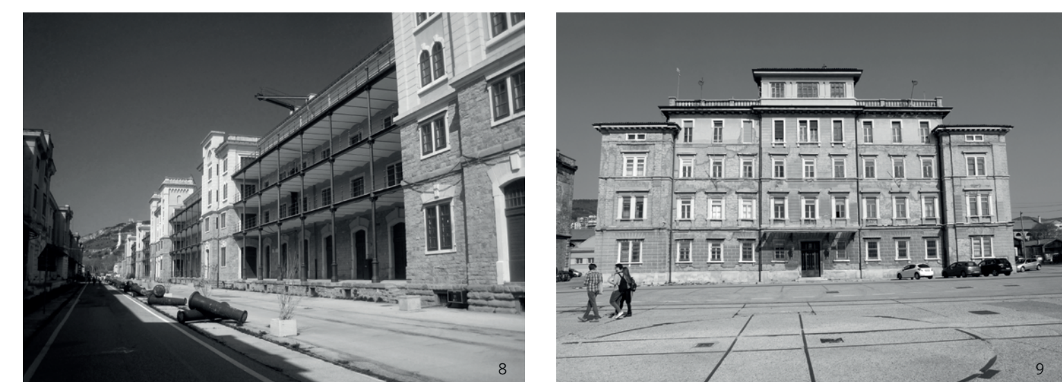
Foto 8: uno degli edifici restaurati e adibiti ad attività museale e di ricerca
