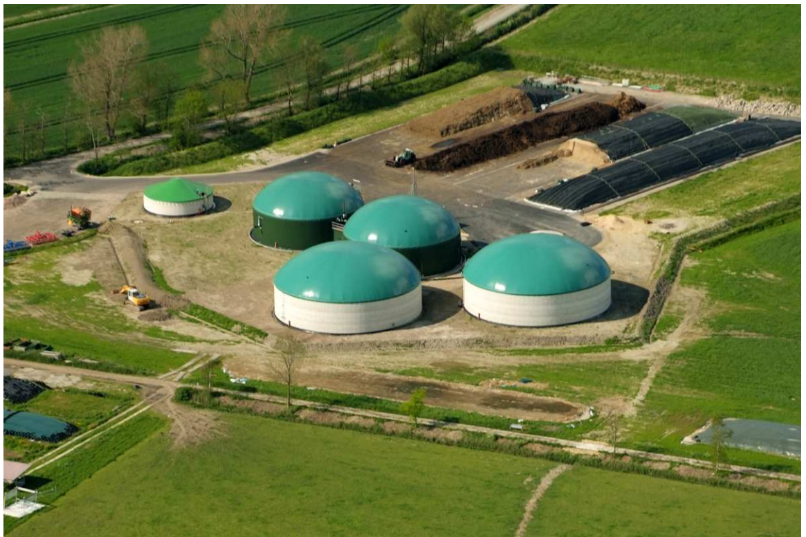
Figura 1.1: Impianto a biomasse per la produzione di biogas.
