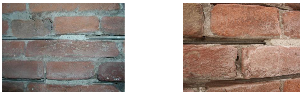
Figura 8.10: Ristilatura dei giunti.
