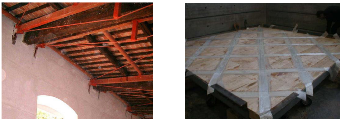
Figura 8.12: Inserimento di irrigidimenti nei solai.
