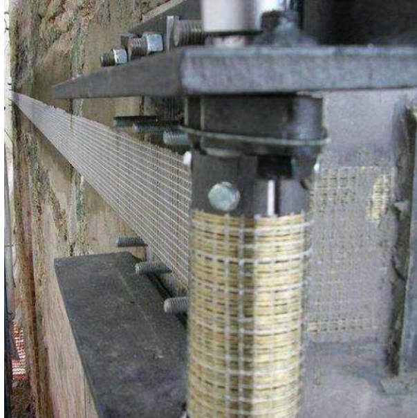
Figura 8.5: Fasciatura in tessuto di acciaio (UHTSS)
