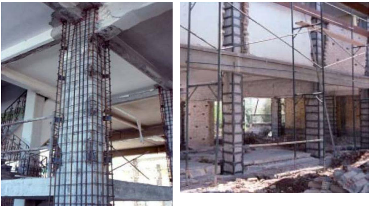
Figura 7.3: Incamiciatura dei pilastri
