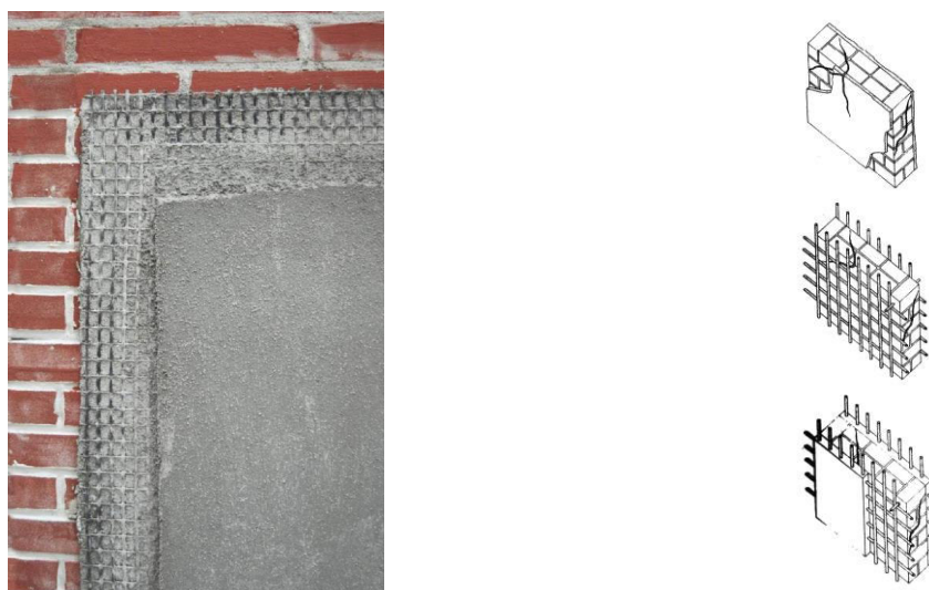
Figura 8.6: Intonaci armati
