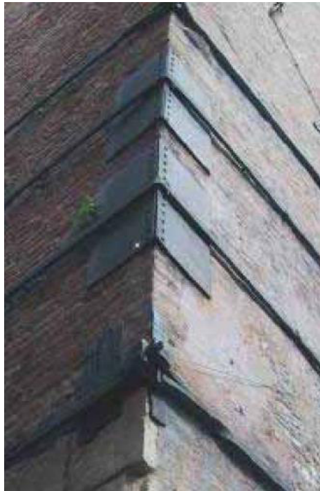
Figura 8.1: Cerchiature degli spigoli
