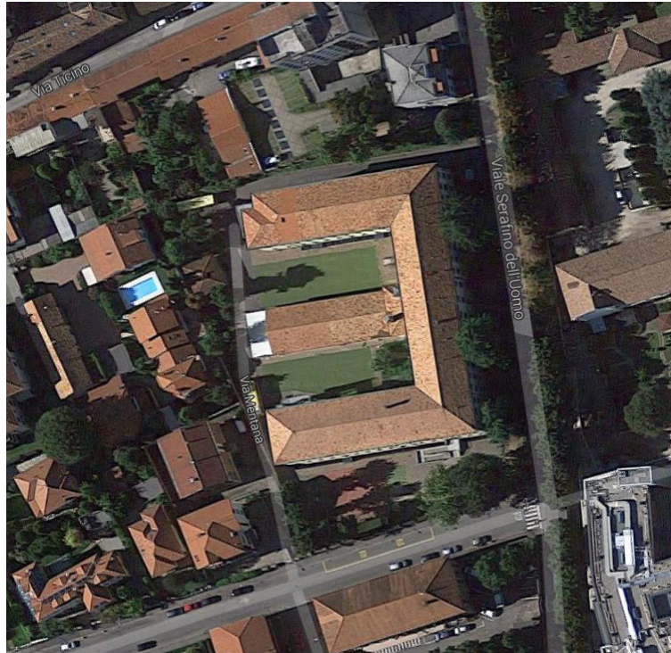
Figura 3.1: Edificio Muratura – vista aerea.
