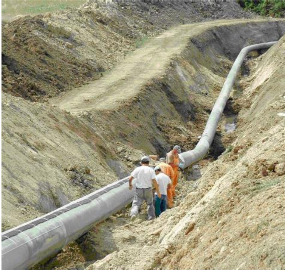
Figura 2.10 Tubature con strumentazione in fibra
