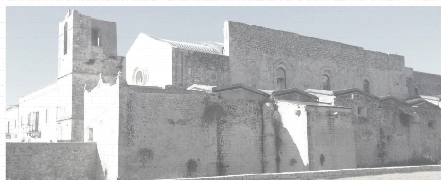
Restauro del Convento di Santa Maria di Gesi, Modica (RG), Italia, 2008 – Emanuele Fidone
