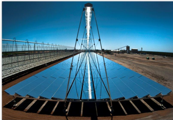
Figura 1-8 Collettori Lineari di Fresnel [32]
