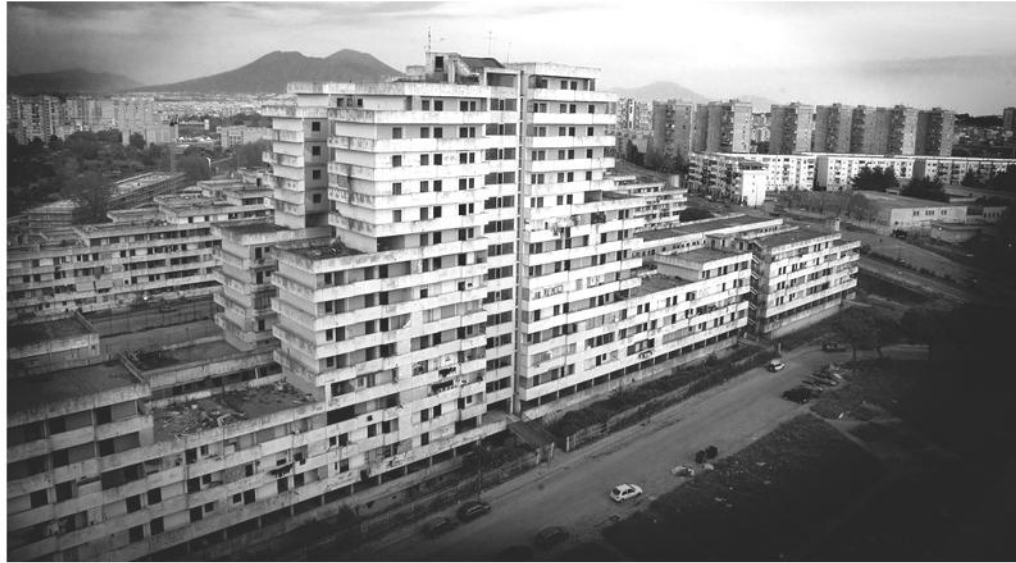
Fig. 7- Quartiere dormitorio - Le vele - Napoli
