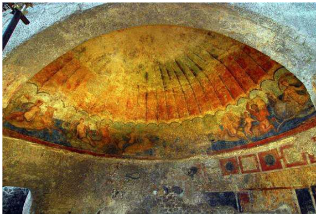
Fig. 66. Abside. Decorazione pittorica
