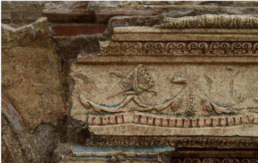
Fig. 8. Particolare del timpano posto sopra la porta centrale dell'esedra
