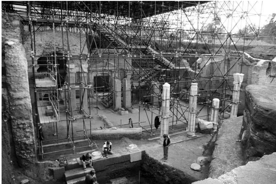
Fig. 1. Visione complessiva dello scavo
