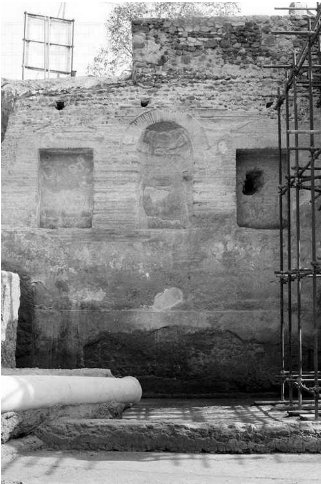
Fig. 17 - Muro con nicchie orientale
