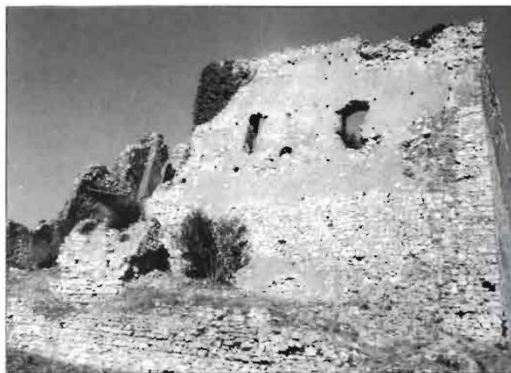
Donjon lato sud (Foto F. Cordella)
