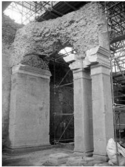
Fig. 11 - Prospetto ad arcate e pilastri: arcata orientale
