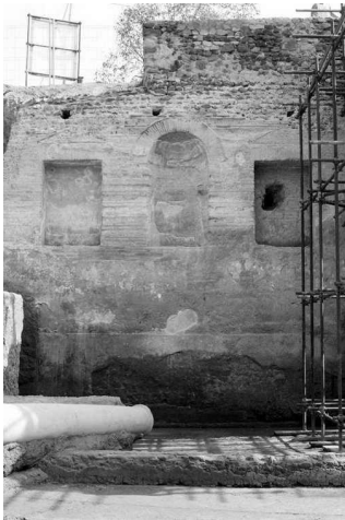
Fig. 17 - Muro con nicchie orientale
