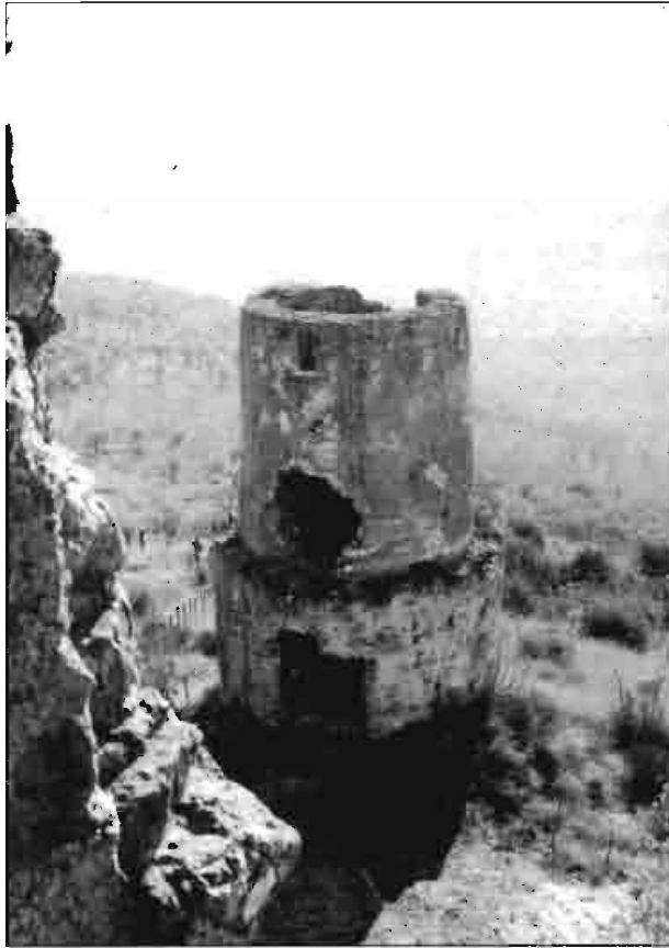
Torre Mulino a vento (Foto F. Cordella)
