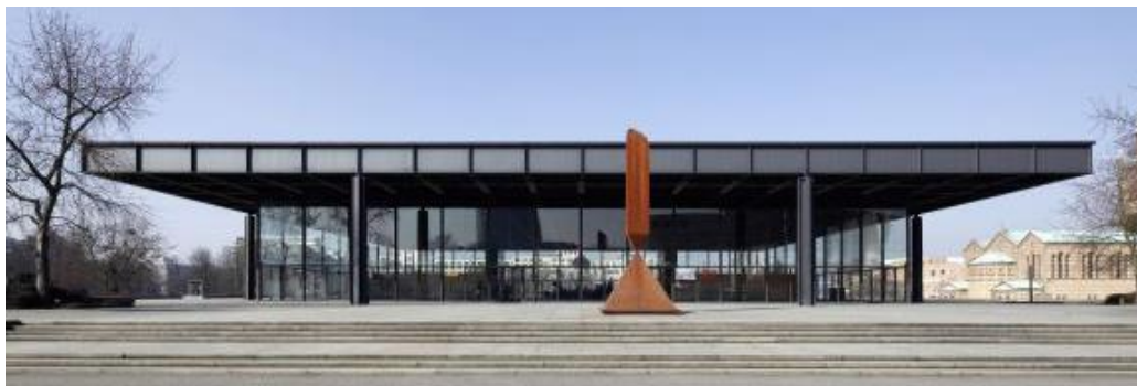
Figura 26. L'immagine rappresenta il prospetto principale della Neue Nationalgalerie. E' possibile notare la copertura a sbalzo e la presenza di esili pilastri cruciformi lungo il suo perimetro.
