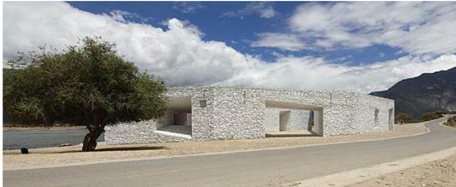
Figura 19. La foto mostra come si presenta l'edificio visto dalla strada.
