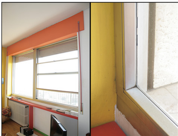
Fig. 16-17 - foto della tipologia di serramento in alluminio che caratterizza il condominio
