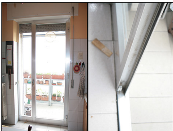
Fig. 18-19 - foto della tipologia di serramento in alluminio che caratterizza il condominio
