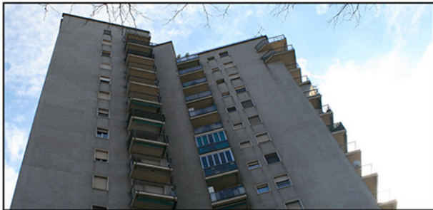
Fig. 11 - foto del fronte ovest
