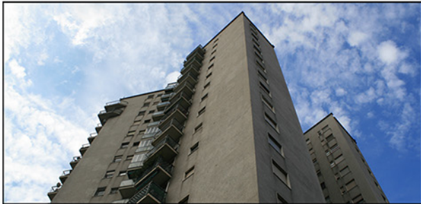
Fig. 10 - foto del fronte nord/est
