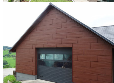
F2.58: Esempi di edificio usando i pannelli di rivestimento FX12
