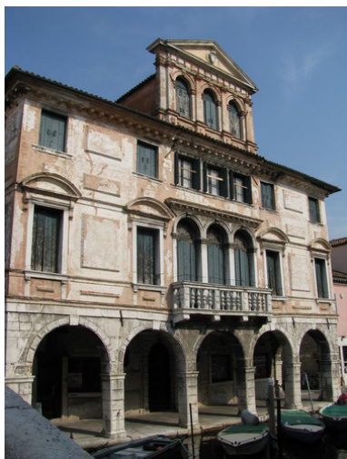
F1.21: Facciata principale del Palazzo Lisatti, vista dal Canale Vena
