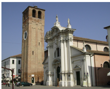
F1.25: Facciata e campanile della Chiesa di Sant'Andrea, affacciata al Corso del Popolo
