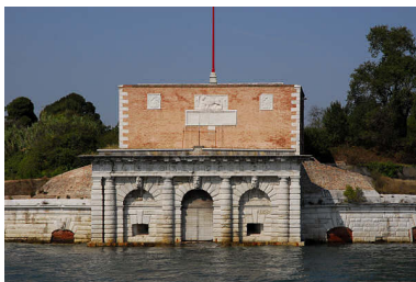
F1.33: Vista frontale del forte di Sant'Andrea
