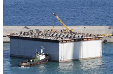
F3.37: Esempio di cassone galleggiante in calcestruzzo
