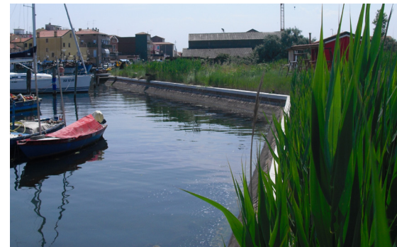
12 - Cantiere visto dal nord
