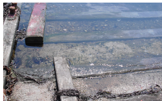
16 - Riva del cantiere
