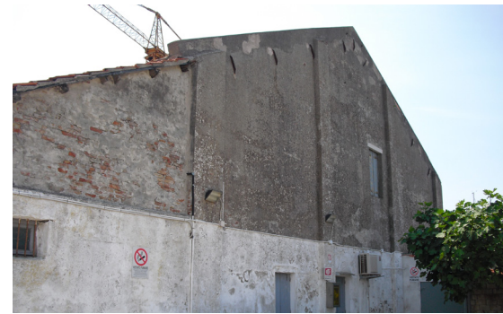
7 - Vista del cantiere navale, lato est
