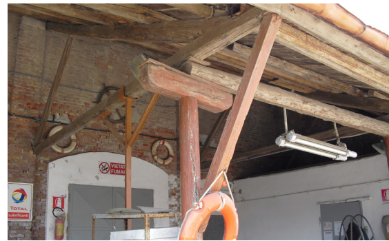
6 - Vista del cantiere navale, lato est
