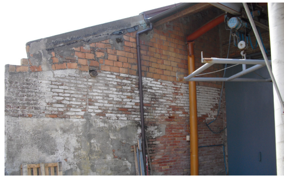
5 - Vista del cantiere navale, lato est
