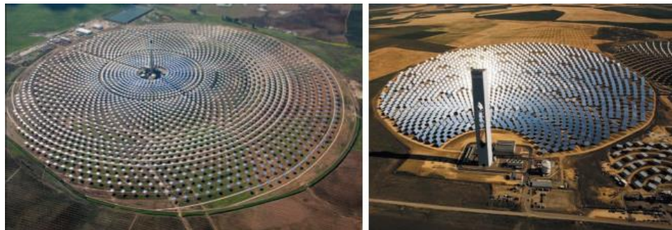
Figura 14: Esempi della disposizione circolare degli eliostati: Gemasolar (sx) [6] e PS10 (dx).
