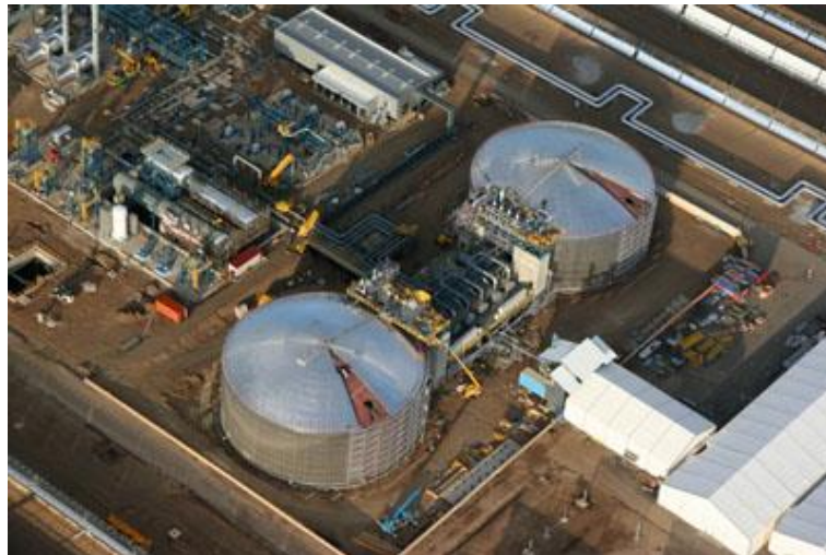
Figura 16: Vista dall'alto dei due serbatoi a livello variabile nell'impianto ANDASOL1 [9].
