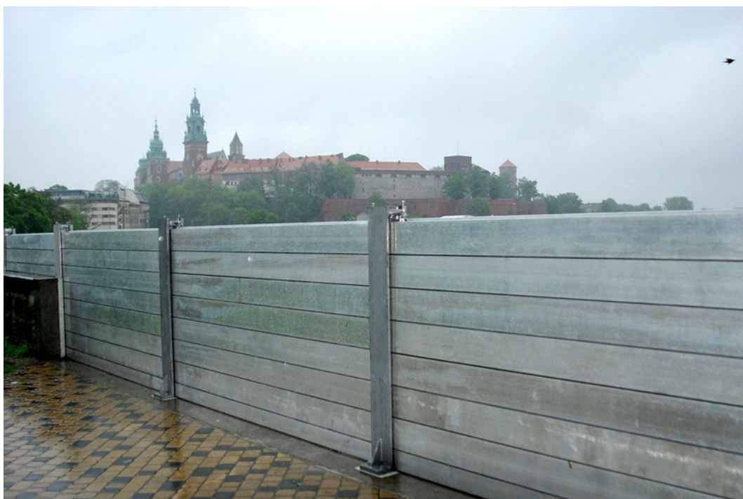
Illustrazione 16: Chiusura di uno dei quattro cancelli sugli argini della Vistola in città durante l'alluvione del 2010 (Wawel.net, foto Artur Turyna).
