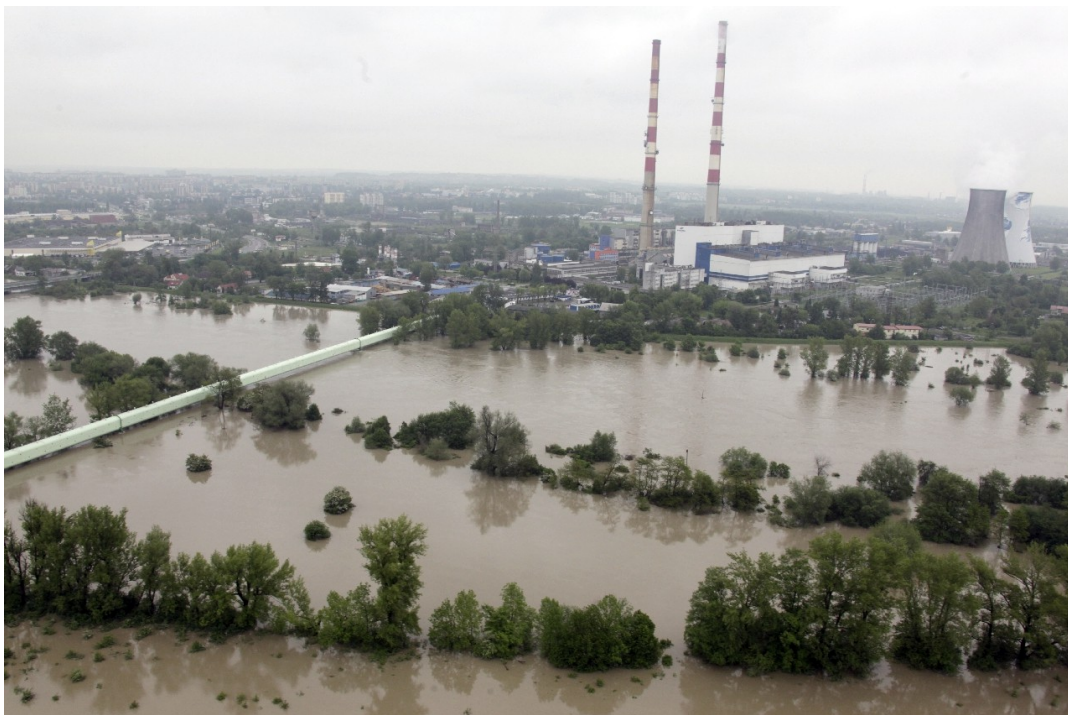
Illustrazione 20: La Vistola durante la piena del 2010 e le aree allagate, con sullo sfondo la centrale elettrica (mykrak.info)
