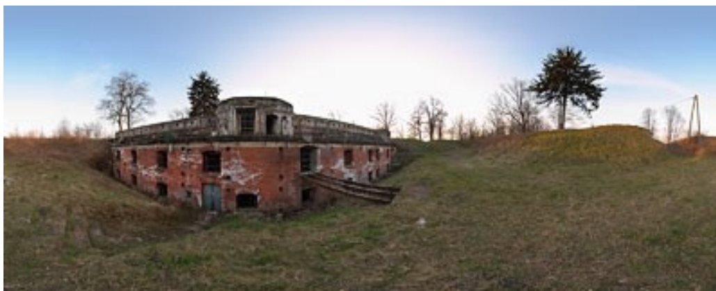
Illustrazione 68: Il forte abbandonato nell'area Skotniki (panoramy.zbooy.pl)
