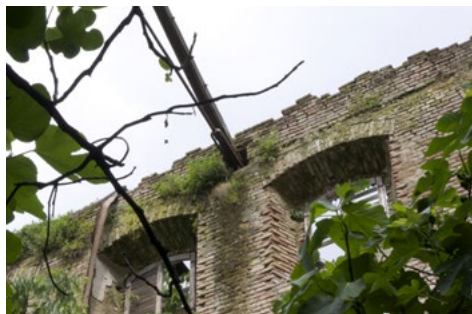
Rilievo fotografico della porzione interna della navata centrale del Macello Suini. In evidenza le finestre dell'ordine superiore strombate nella parte interna e l'alloggiamento ricavato nella muratura per l'arrivo della capriata.
