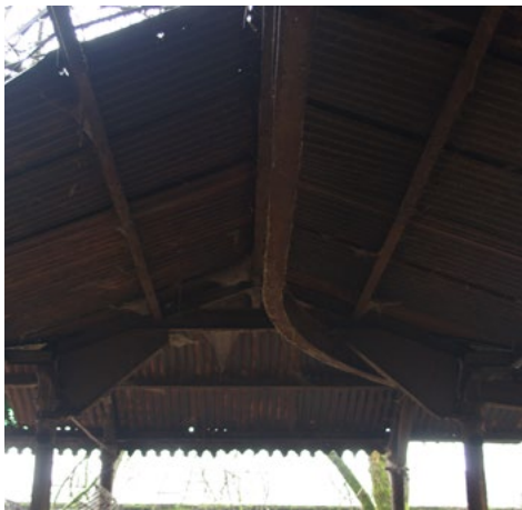
Fotografia del portico esterno: in alto la presenza della guidovia.
