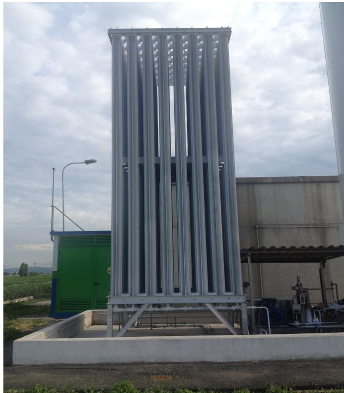
Figura 3.10: Vaporizzatore dell'impianto di Calderara di Reno (BO).
