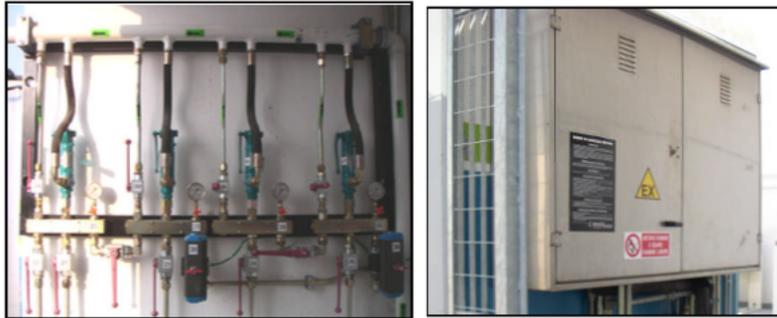
Figura 3.5: Pannelli di controllo dell'impianto CNG
