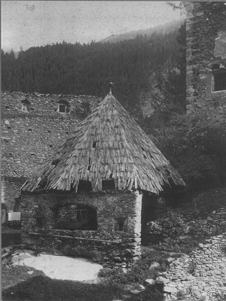
43. Fotografia della fucina con in secondo piano le mura di cinta sbrecciate in seguito al crollo del mastio (Archivio fotografico della Soprintendenza di Bolzano, n.23693)
