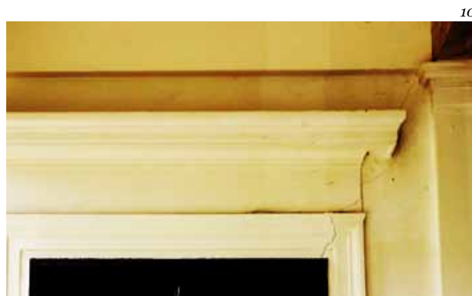
3.64. Fotografie delle fessurazioni osservate sugli architravi e sulle pareti laterali della parte centrale dei Portici Meridionali. Le foto sono state rielaborate in modo da mettere in evidenza le lesioni
