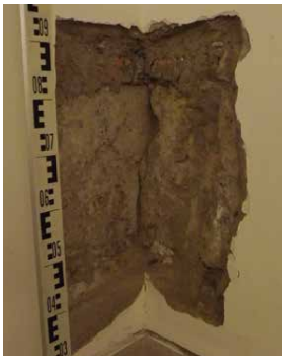
4.24. Verifica Ammortamento I10: localizzazione (1), immagine reale (2), elaborazione grafica (3), schizzo di cantiere (4). Si può notare la perfetta corrispondenza tra i corsi di blocchi di tufo e l'altrettanto corretto incastro.
