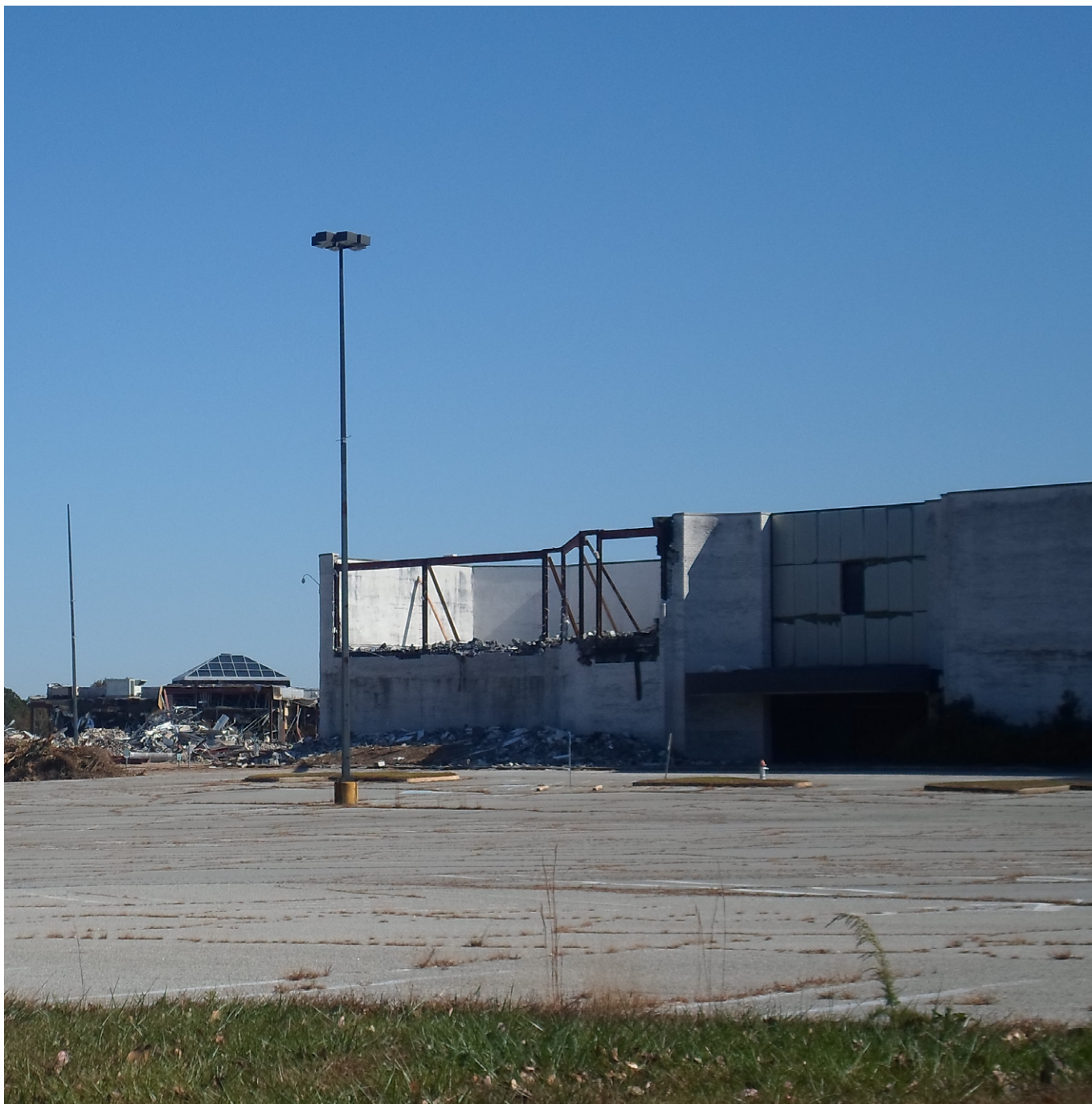
Fig. 385-Shannon Mall durante la demolizione, ottobre 2014 Fig. 385-Shannon Mall during demolition, October 2014
