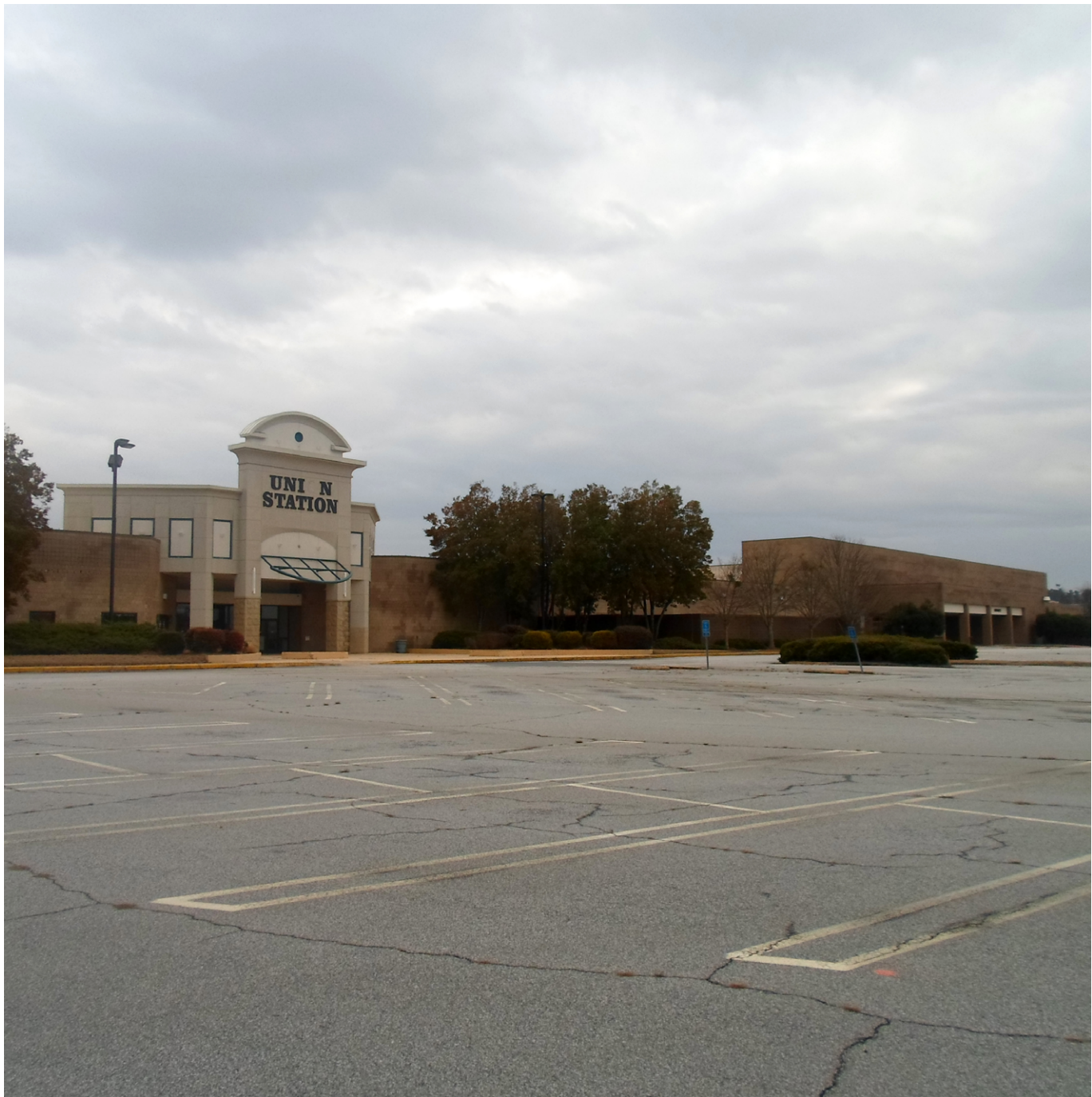
Fig. 377-Shannon Mall durante il periodo di chiusura, gennaio 2014 Fig. 377-Shannon Mall during the period of closure, January 2914
