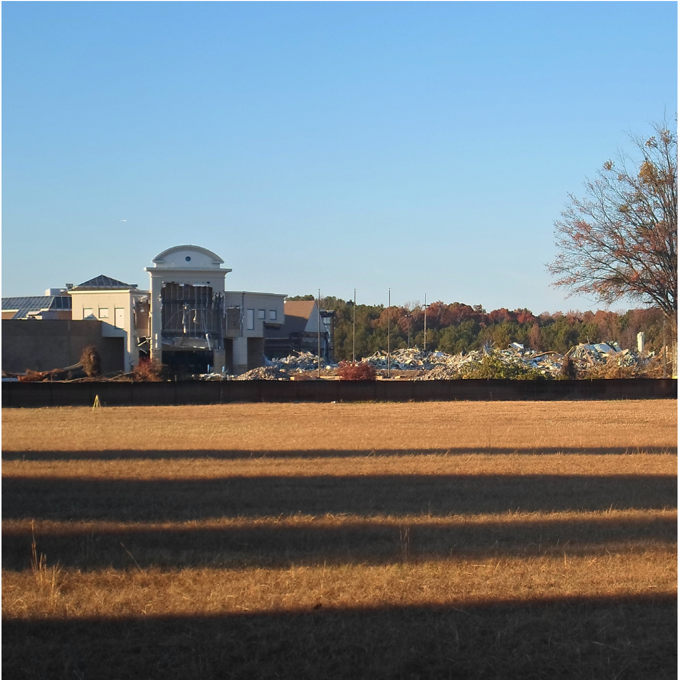
Fig. 386-Shannon Mall durante la demolizione, ottobre 2014 Fig. 386-Shannon Mall during demolition, October 2014
