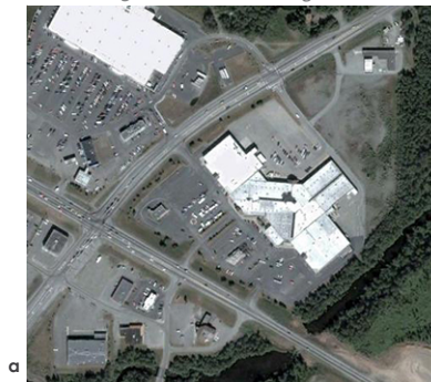
Fig. 095a,b -Immagine satellitare e schema di Cottonwood Creek Mall, Wasilla, AK prima del demalling Fig. 095a,b-Satellite image and scheme of Cottonwood Creek Mall, Wasilla, AK before the demalling
