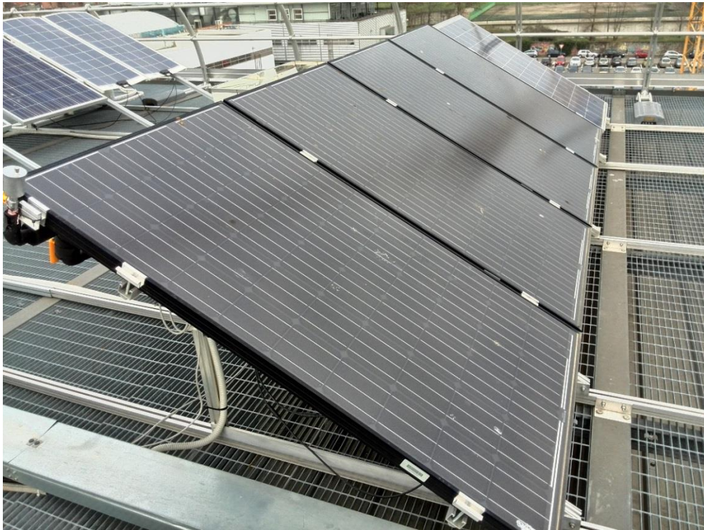
Figura 3.6 - Collegamento in serie di quattro pannelli PVT Fototherm
