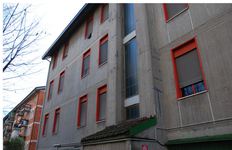
FOTO 4_PROSPETTO NORD: vista prospettica
