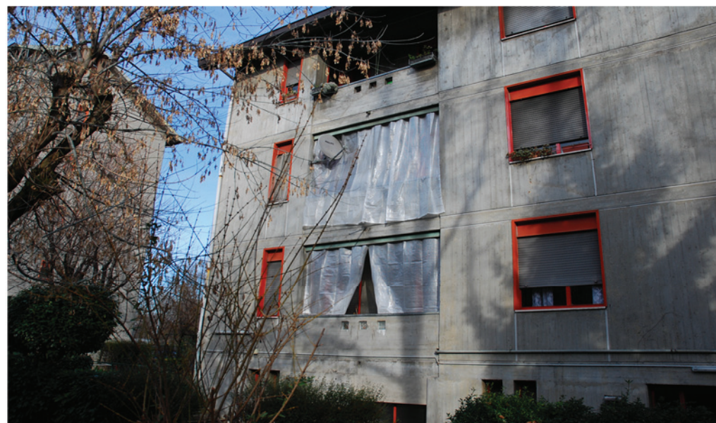
FOTO 4_PROSPETTO SUD: vista prospettica
