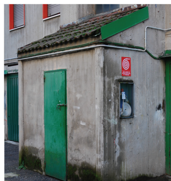
FOTO 5_PROSPETTO NORD: locale deposito
