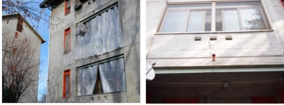
Figura 3.22, Vista delle logge del prospetto sud-ovest con le schermature solari installate dagli utenti
