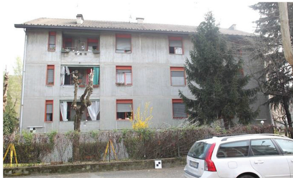
FOTO 1_PROSPETTO SUD: vista prospettica
