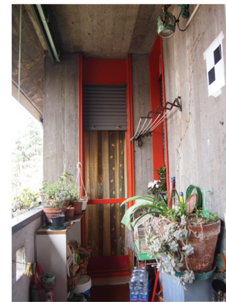
FOTO 3_PROSPETTO SUD: interno loggia
