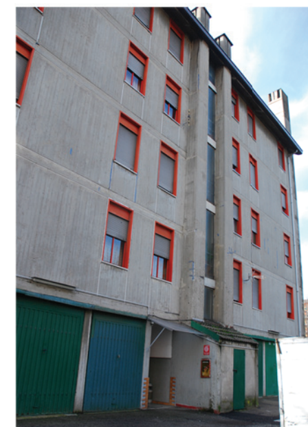
FOTO 3_PROSPETTO NORD: ingresso secondario
