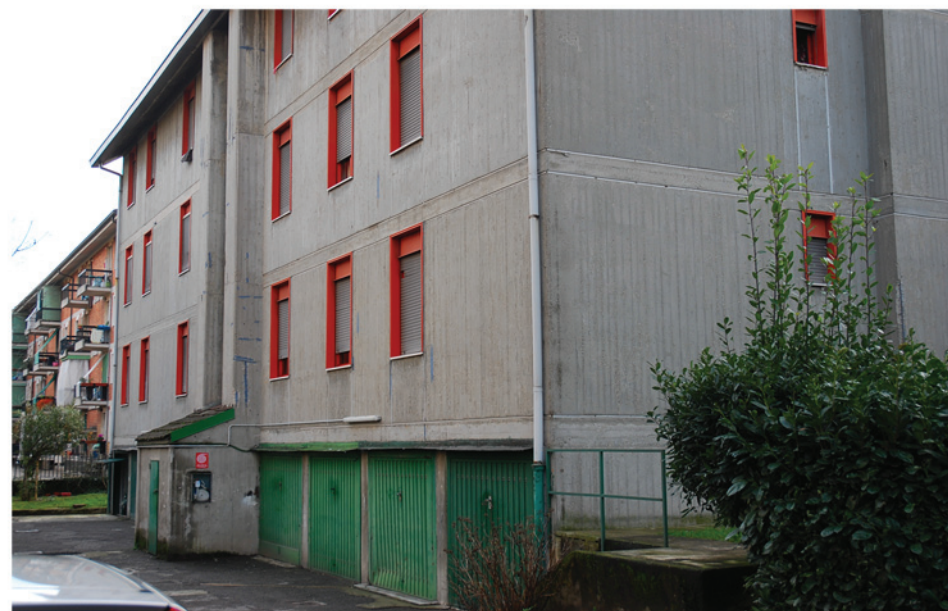
FOTO 1_PROSPETTO NORD: vista prospettica
