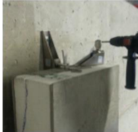
Figura 6.13, Ganci Halfen per ancoraggio pannelli EASEE. Fonte Politecnico di Milano
