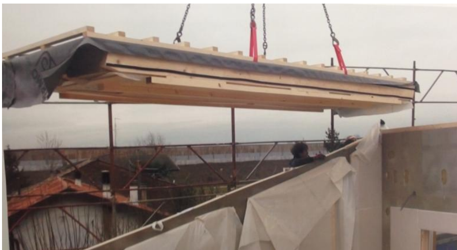
Figura 6.23, Esempio di movimentazione di un pannello prefabbricato
