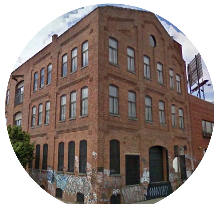
EDIFICIO INDUSTRIALEE STORICO DOTATO DI PARAMENTO ESTERNO IN MATTONI SCANDITO DA LESENE E MARCAPIANI SEGNA L'ACCESSO AL NUOVO COMPARTO INDUSTRIALE
