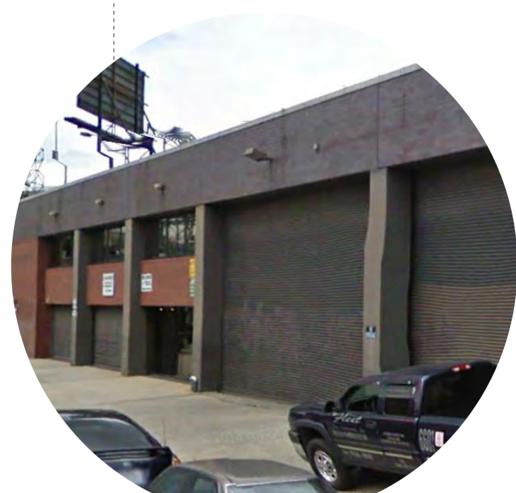
EDIFICIO INDUSTRIALE A PIASTRA DOTATO DI OMOGENEITA' E COMPATTEZZA
