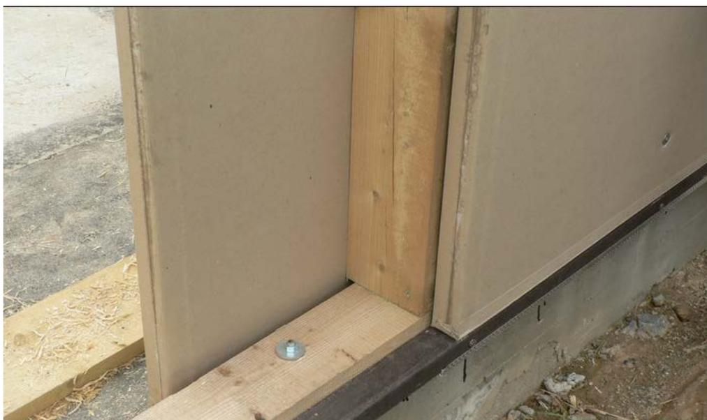
Figura 88 - Sistema Ekopanel a doppio pannello con montanti di rinforzo in legno
