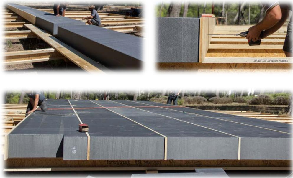
Figura 84 - Messa in opera del solaio in travetti di legno e blocchi di isolante
