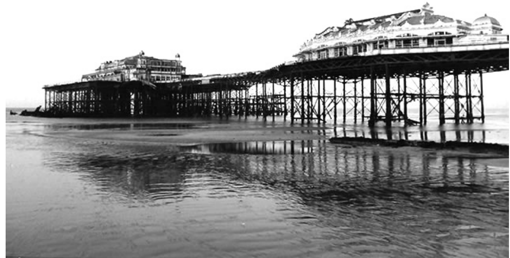
West Pier negli anni'80, poco dopo la chiusura definitiva.
