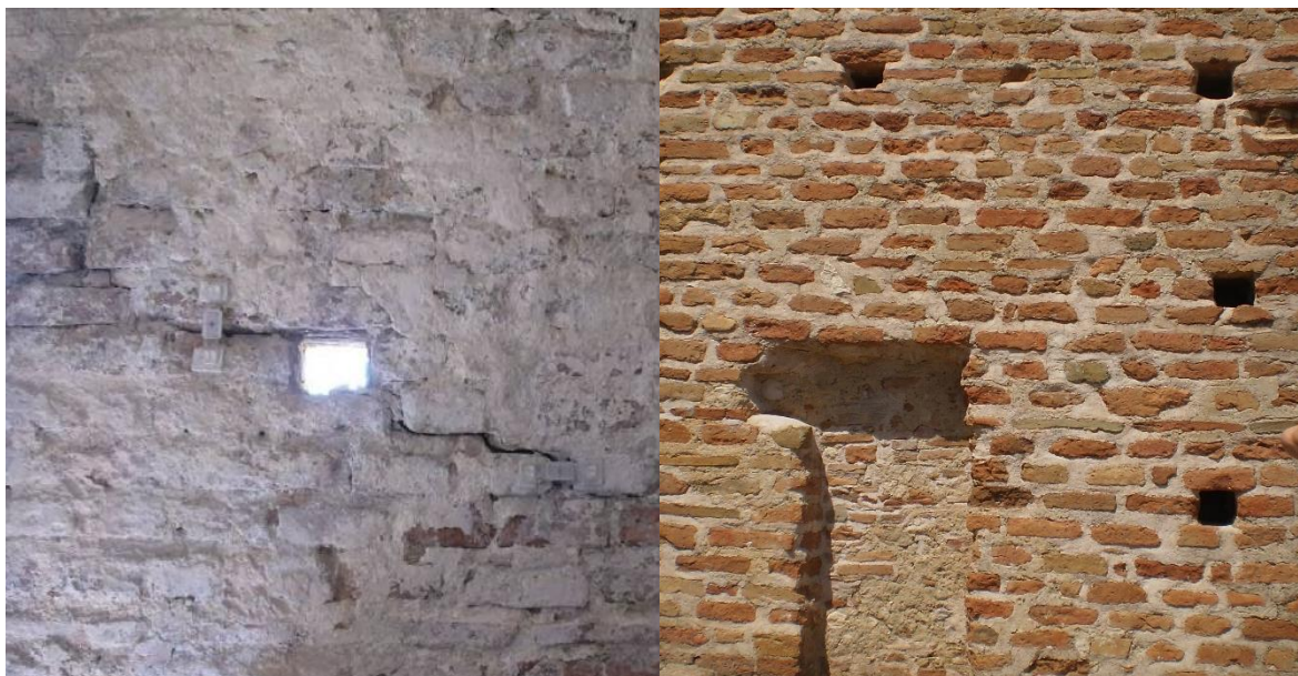
Figura 3.36 – Dettagli della muratura, dall'interno e dall'esterno.
