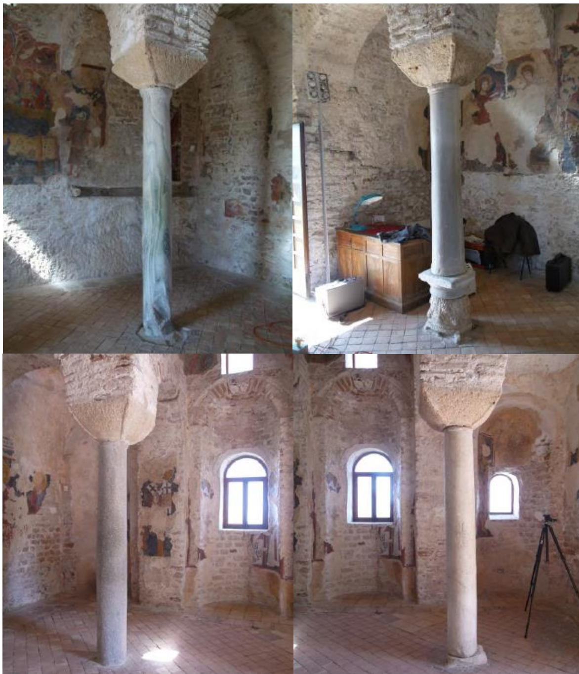
Figura 3.20 – Dettagli delle colonne, in ordine: colonna di marmo verde venato a nord ovest, colonna di marmo angelo sud ovest, colonna di granito angolo nord est e colonna di marmo bianco angolo sud est.
