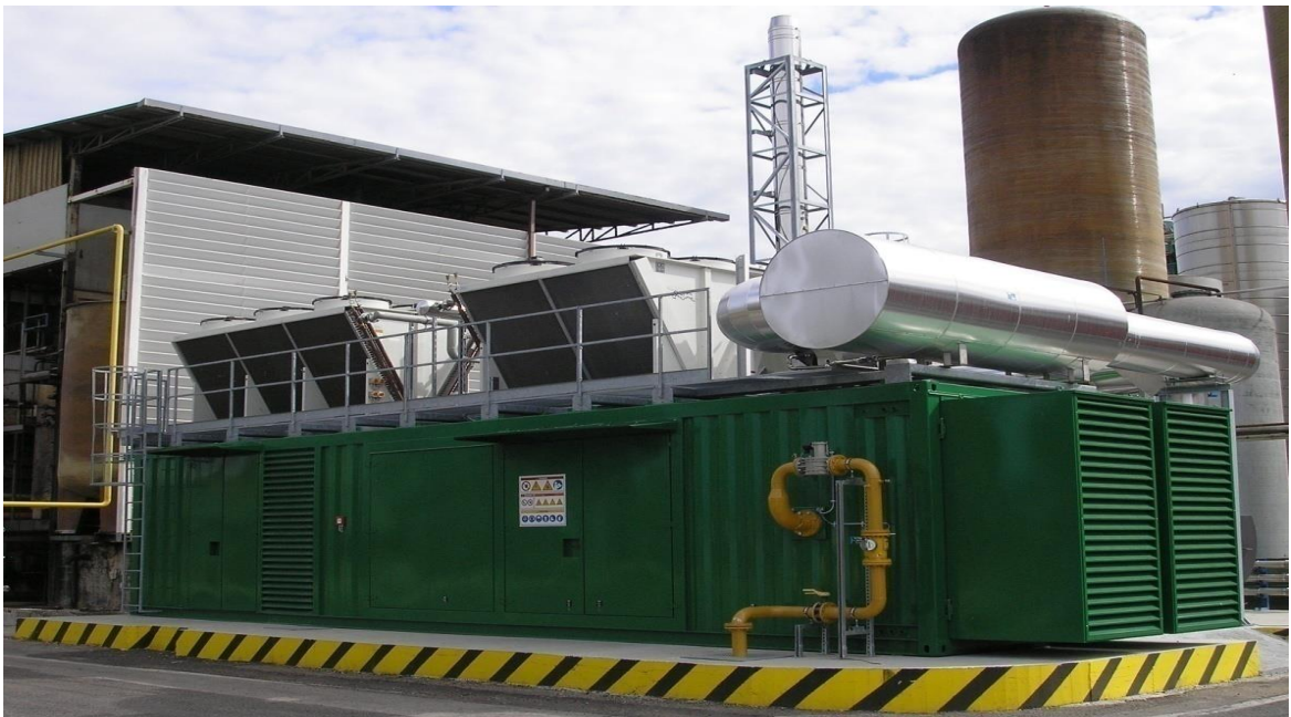
Figura 44: Motore GE Jenbacher J320 GS-C02 DPL
