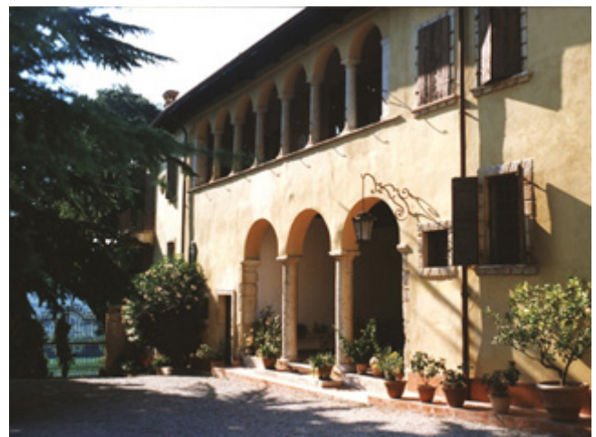
Fig.52 - Prospetto principale del corpo di fabbrica più antico (risalente al XVI-XVII secolo) caratterizzato da un breve tratto di porticato al piano terra e da un loggiato a 7 archi al piano nobile.
