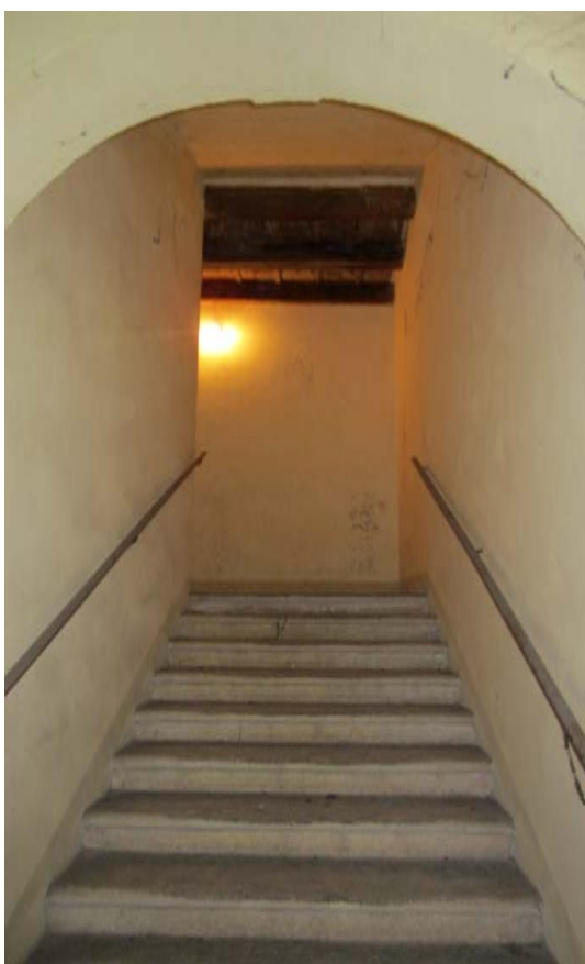
Fig. 46 - Vista verso Nord della rampa ascendente della scala.
