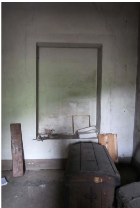
Fig.55 - Sul lato Nord del vano si può notare una finestra tamponata, forse segno dell'antico perimetro della villa.
