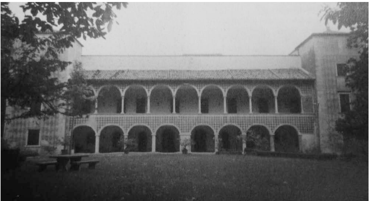
Fig.24 - Vista del prospetto Sud di villa Cologne-Brenzoni caratterizzato dal suo nucleo originario aperto da portico e loggia e dalle due possenti torri colombari che ne delimitano le estremità.
