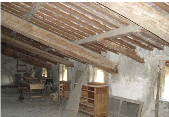
Fig.95 - Vista del solaio ligneo di copertura inclinato di 20°.
