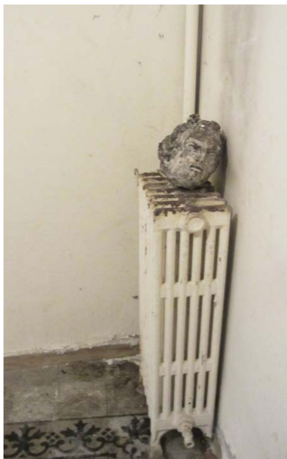
Fig.22 - Dettaglio del calorifero, collocato nell'angolo Nord-Est del vano, sul quale è stato posto il capo danneggiato appartenente alla statua della Primavera del Muttoni attualmente nel giardino della villa.
