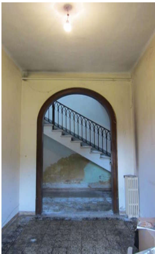
Fig.16 - Vista dell'atrio d'ingresso verso il vano scala a Nord incorniciato dal grande arco nella muratura.
