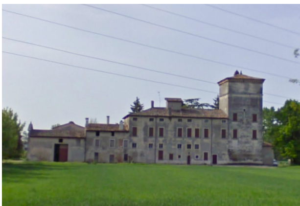
Fig.15 - Vista del prospetto Nord del complesso di villa Ridolfi-Cossali. Il fronte appare privo di rilevanti decorazioni architettoniche e di accessi diretti verso l'esterno avvicinando la villa ad una fortificazione.
