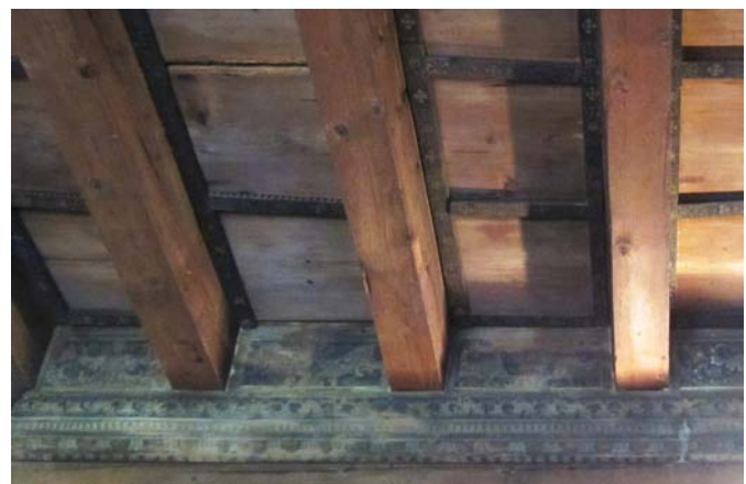
Fig. 79 - Dettaglio delle pettenelle perimetrali decorate con motivi floreali e vegetali simili a quelli presenti in fascia sulla loggia: si può far risalire tale decorazione ad un'epoca anteriore rispetto a quella parietale ottocentesca.
