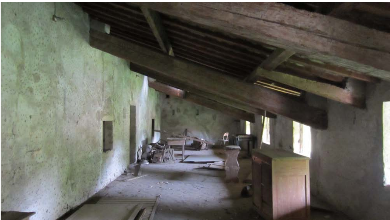
Fig.93 - Vista verso Est del locale soffitta. Questo grande stanzone si affaccia a Sud sul cortile della villa attraverso 5 piccole finestrelle.
