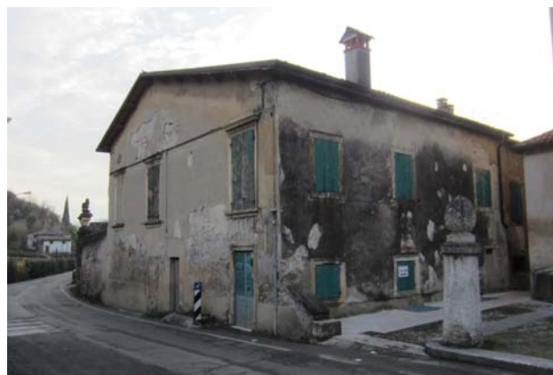
Fig.16 - Prospetto Nord-Est di villa Rotàri-Cartolari affacciato direttamente sul sagrato della chiesa di S. Martino di Avesa. La facciata appare priva di elementi decorativi di qualche pregio artistico risultando spoglia ed essenziale.
