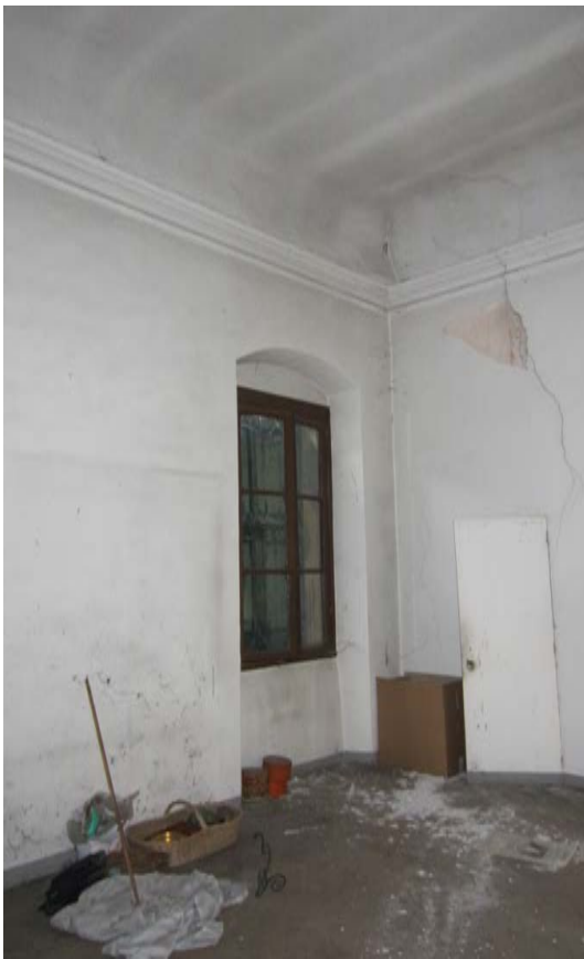
Fig.60 - Vista Sud-Ovest del grande stanzone con accesso diretto verso i servizi igienici di cui è possibile vedere la piccola apertura.
