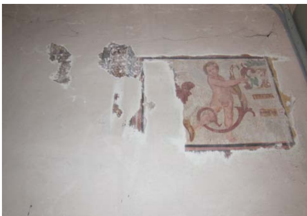
Fig.72 - Particolare della decorazione in fascia precedentemente intonacate dai militari e successivamente venuta alla luce dopo un intervento di scialbatura.
