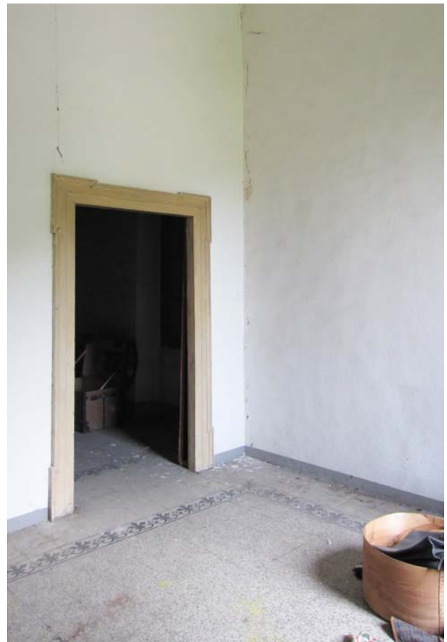
Fig.59 - Angolo Nord-Est della stanza verso la camera 2.3 appena descritta.
