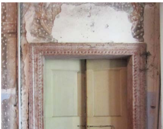
Fig. 78 - Particolare della porta sul lato Est impreziosita dalla cornice in marmo rosso di Verona, probabilmente appartenuta al demolito monastero delle agostiniane in quanto simile all'arco che troveremo poi nell'ala Ovest.
