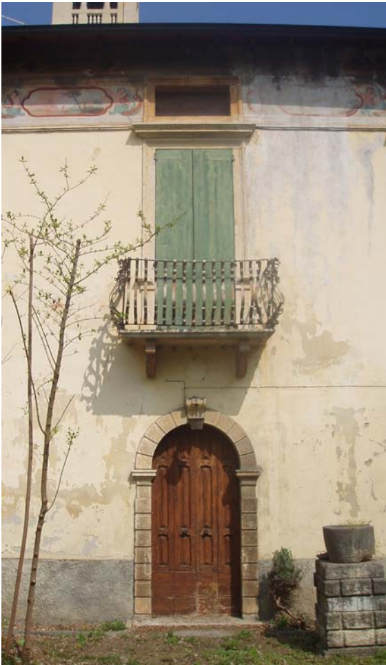
Fig.110 - Particolare del portone archivoltato d'ingresso, collocato verso Est, e del balcone sovrastante realizzato in pietra Galina con ringhiera in ferro battuto.
