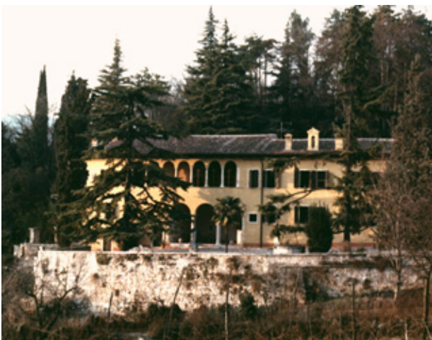
Fig.51 - Vista del complesso di villa Peruzzi. La villa è composta da varie costruzioni di diverse epoche addossate tra loro: il palazzetto centrale, le case accessorie ed i rustici.
