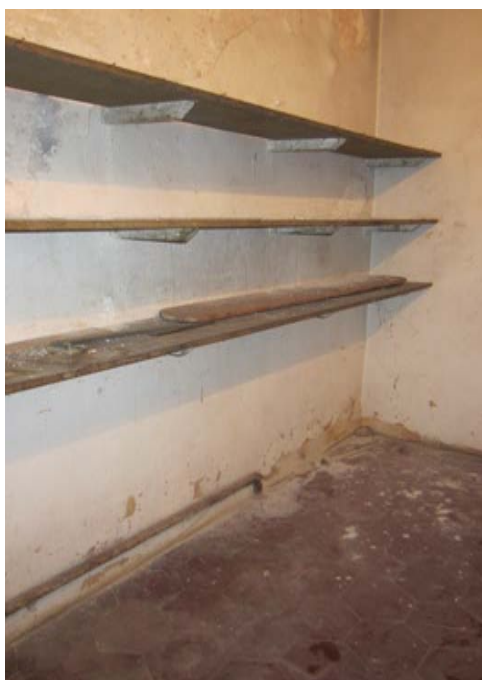
Fig.26 - Angolo Nord-Est dell'interno della dispensa. Da notare il pavimento in cotto di antica fattura.
