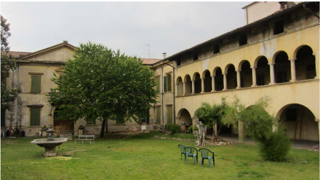
Fig.6 - Vista dei due prospetti principali del complesso di villa Rotàri-Cartolari. A destra è visibile il nucleo quattrocentesco con il loggiato sovrapposto al portico e, a sinistra, parte del fabbricato aggiunto durante i lavori di ampliamento avvenuti nel corso della prima metà del XIX secolo.
