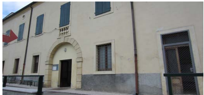
Fig.117 - Nuova facciata Ovest verso i campi sportivi
