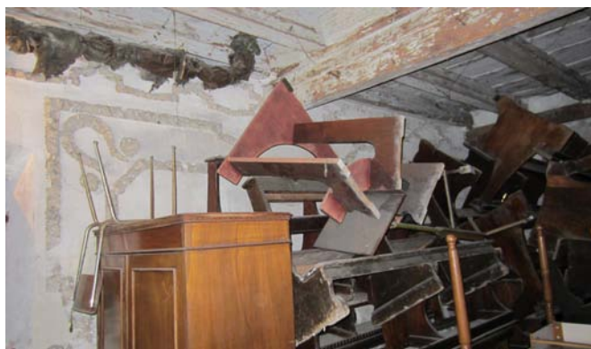
Fig.44 - Sulla parete Est del vano si possono notare i mobili e altri elementi d'arredo, di appartenenza della parrocchia di S. Martino, depositati e accatastati in modo da rendere pressoché impossibile una visione globale della stanza.
