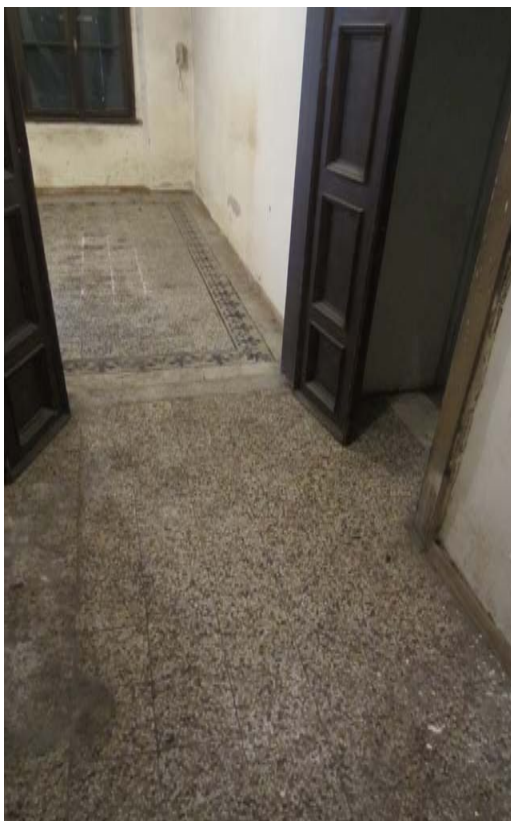
Fig.23 - Vista del disimpegno e dettaglio della pavimentazione realizzata con mattonelle in graniglia.
