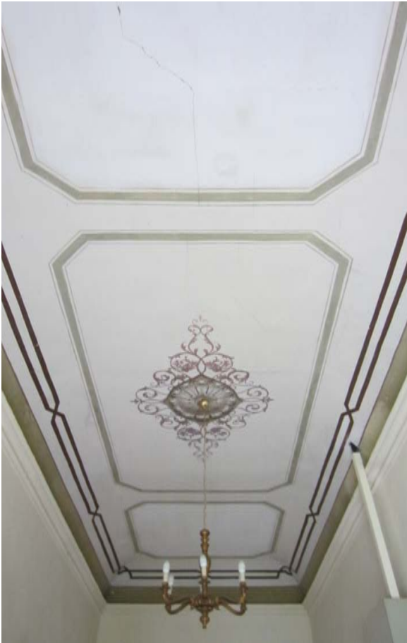
Fig.105 - Vista interna del salone posto sopra il passaggio porticato del piano terra.
