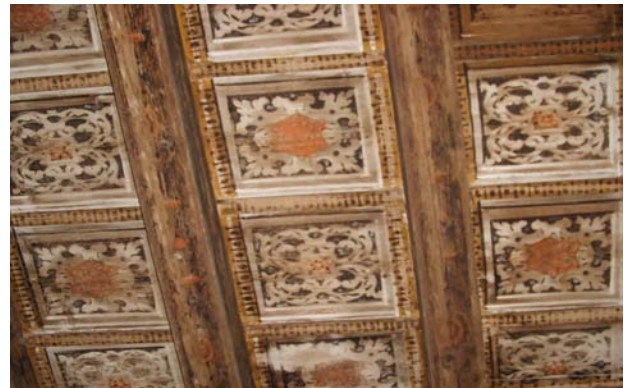
Fig.85 - Dettaglio del soffitto decorato del pianerottolo del vano scala.
