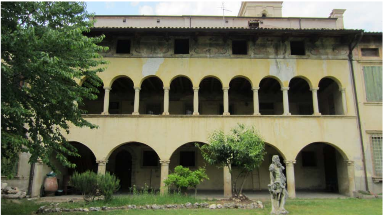
Fig.109 - Prospetto Sud del nucleo più antico della villa (presumibilmente '400) con il sistema a portico e loggiato sovrapposto.
