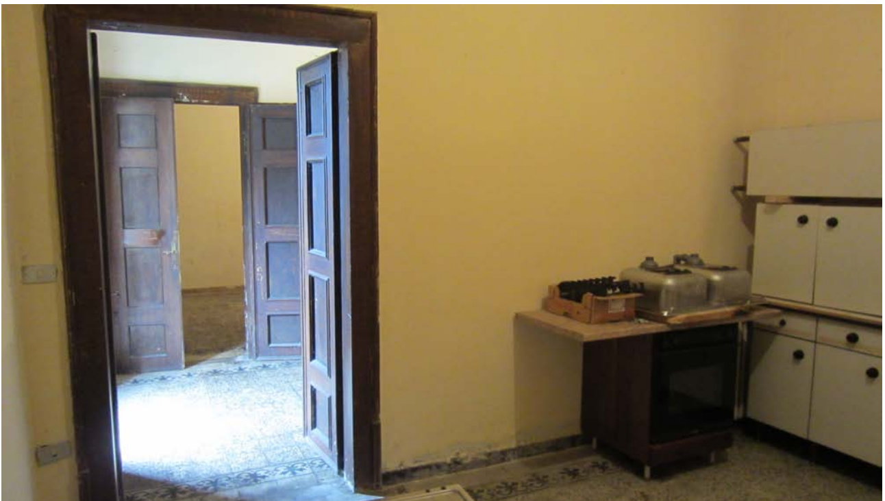
Fig.20 - Vista del lato Ovest del locale verso il luminoso atrio d'ingresso della villa. Si possono qui notare le porte delle due stanze disposte simmetricamente rispetto al disimpegno dell'entrata.
