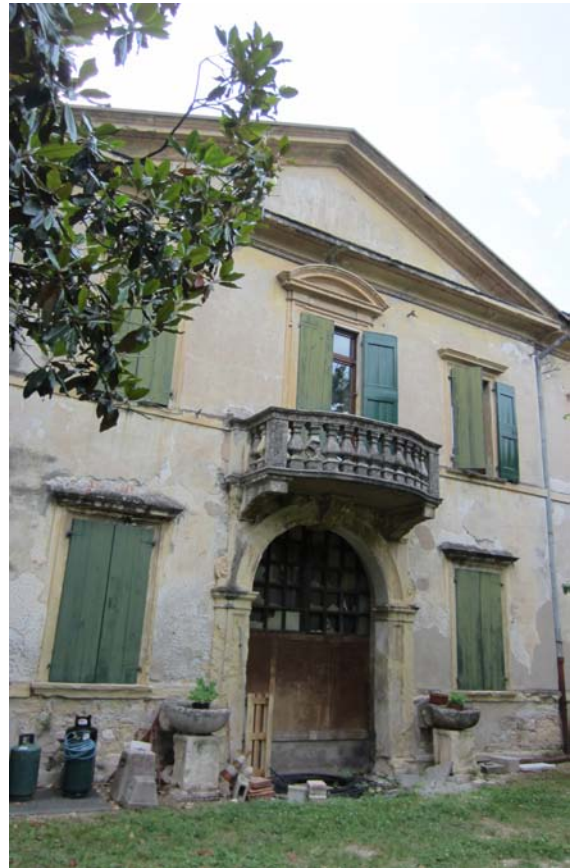
Fig.101 - Prospetto Est dell'ala ottocentesca della villa. Presenta ancora la sua conformazione originaria anche se danneggiata dal tempo e dalla mancata manutenzione.
