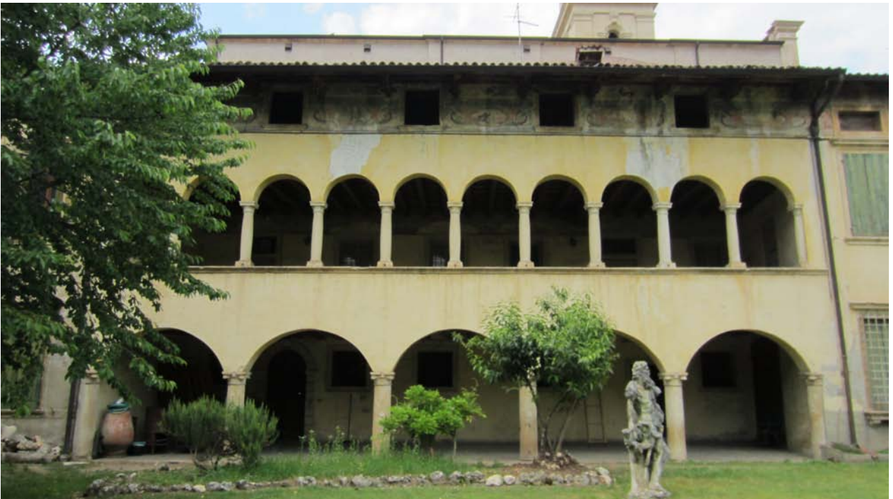
Fig.36 - Prospetto principale del nucleo quattrocentesco di villa Rotari-Cartolari caratterizzata dai tipici tratti dell'architettura urbana rinascimentale con la consueta presenza del porticato ad archi al piano terra e del loggiato con archi a luci più ridotte al piano nobile.
