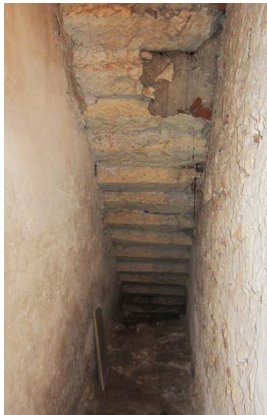
Fig.24 - Antico sottoscala che oggi appare murato e non più accessibile.
