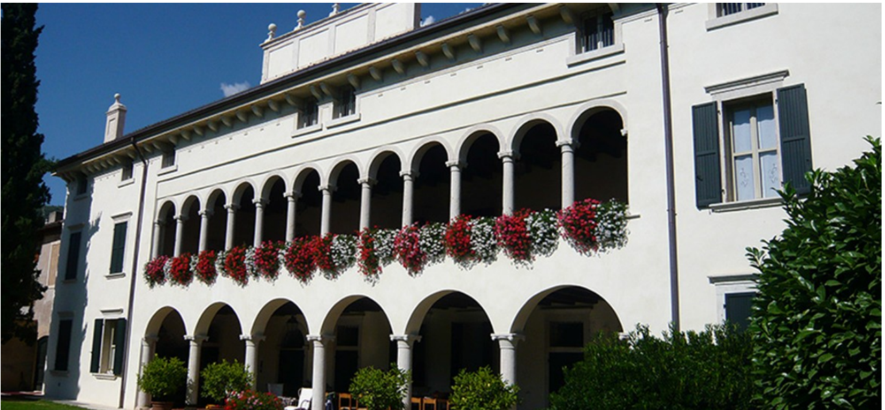
Fig.57 - Vista del prospetto principale del corpo padronale (di origine quattrocentesca) caratterizzato da un affaccio sulla corte antistante per mezzo di portico a 6 arcate che si raddoppiano al piano superiore. Il complesso di villa Selle si compone anche di due ali laterali disposte ortogonalmente al corpo padronale, di origine settecentesca, che ospitavano le attività rurali: stalle, fienili, rimesse, scuderie oggi parzialmente demolite.
