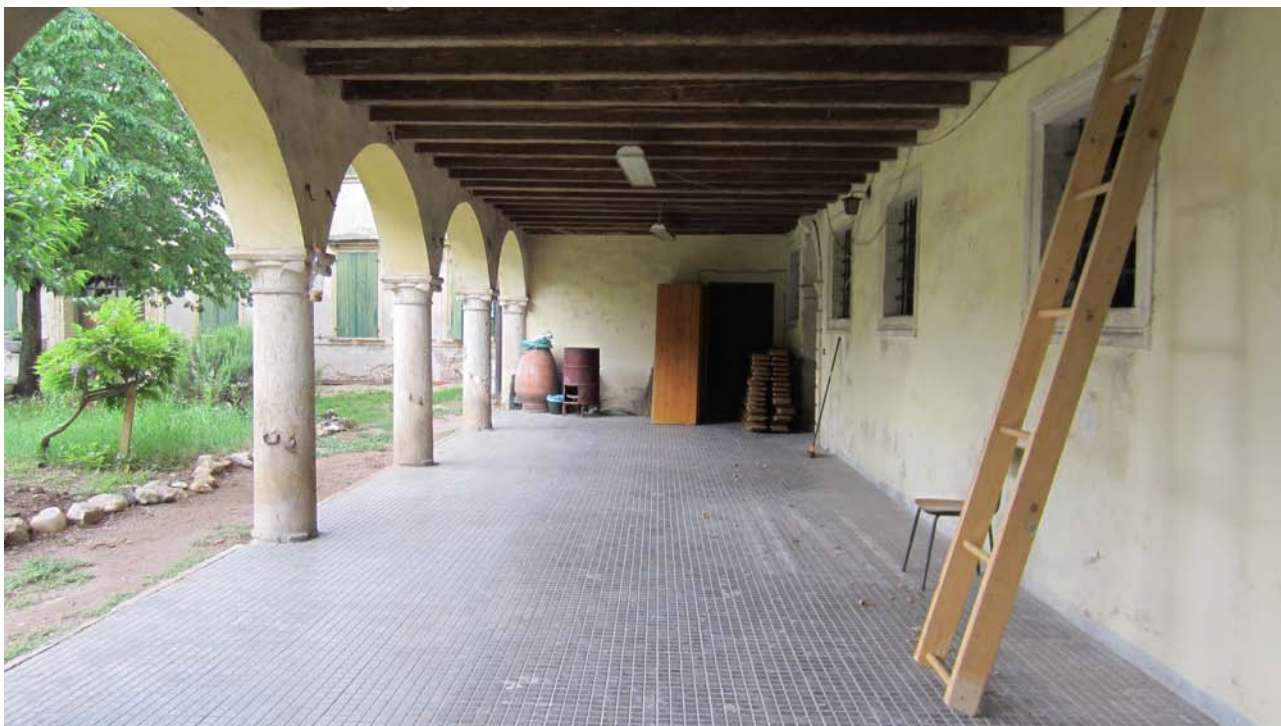
Fig. 30 - Vista verso Ovest da sotto il portico. In evidenza il solaio ligneo, caratterizzato da travetti a sezione e passo costanti, risalente al XV secolo.
