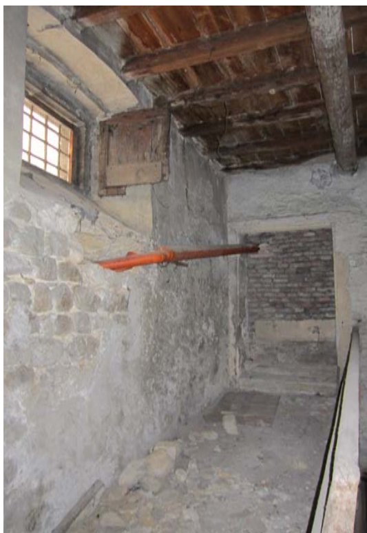
Fig.40 - Vista verso il passaggio murato che consentiva il collegamento con l'appartamento affacciato sul sagrato della chiesa. Questo appartamento, disposto su due piani, era di proprietà dei conti Rotàri e da loro veniva dato in affitto.
