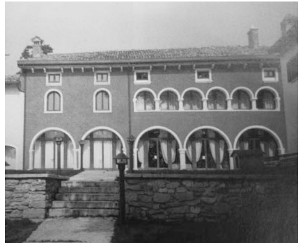
Fig.56 - Prospetto del corpo principale e più antico di villa Ruffoni risalente al XV secolo e caratterizzato dalle tipiche aperture a portico e loggiato.
