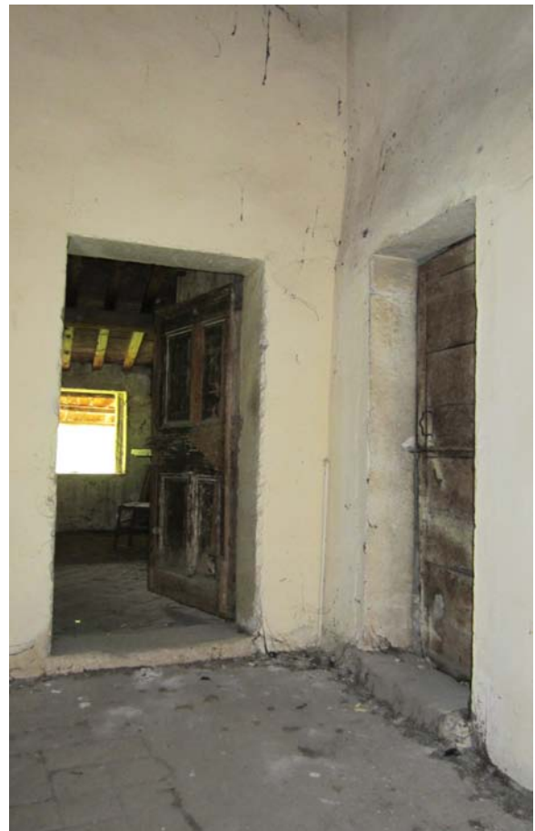
Fig.90 - Pianerottolo del vano scala. A Sud l'accesso verso il grande locale della soffitta mentre a Ovest il collegamento, oggi chiuso, verso l'ala ottocentesca della villa.
