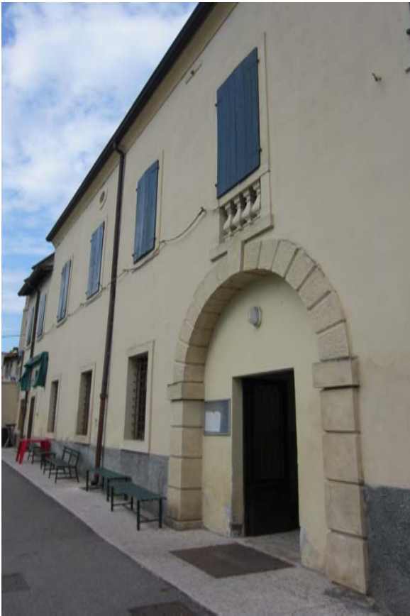
Fig.100 - Prospetto Ovest dell'ala ottocentesca della villa. Attualmente si presenta tinteggiata e modificata perdendo i caratteri originari tipici dello stile neoclassico.
