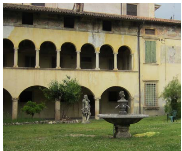
Fig.34 - Vista attuale dell'antica fontana in pietra che sorge al centro del bel giardino di villa Rotàri-Cartolari.
