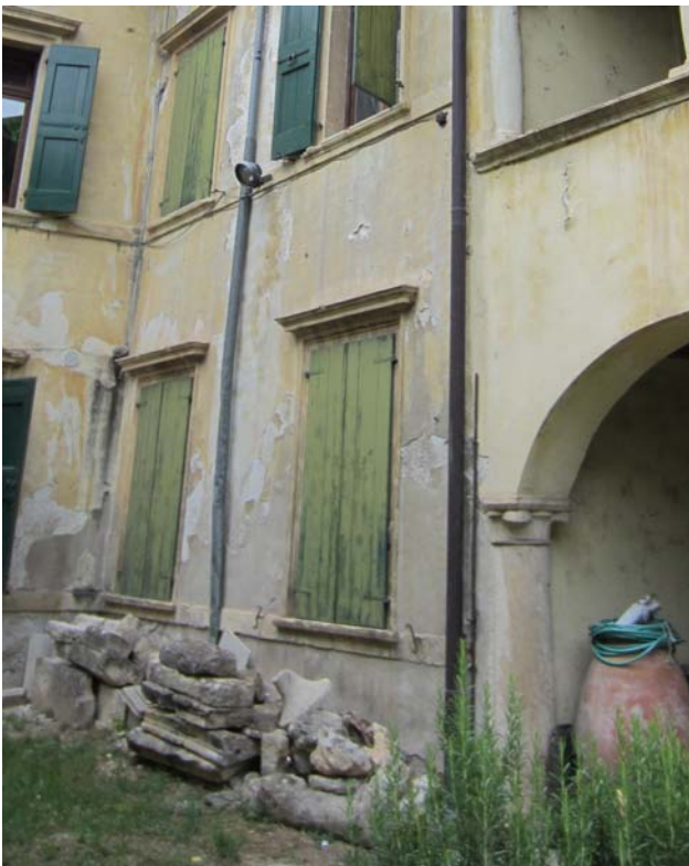
Fig.134 - Angolo Nord-Ovest del giardino dove sono accatastati alcuni frammenti che appartenevano all'antico monastero delle agostiniane.
