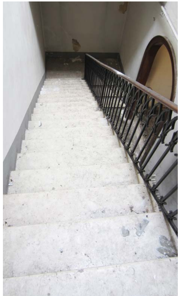
Fig.19 - Vista delle due rampe realizzate in marmo lucido e della ringhiera lavorata in ferro.
