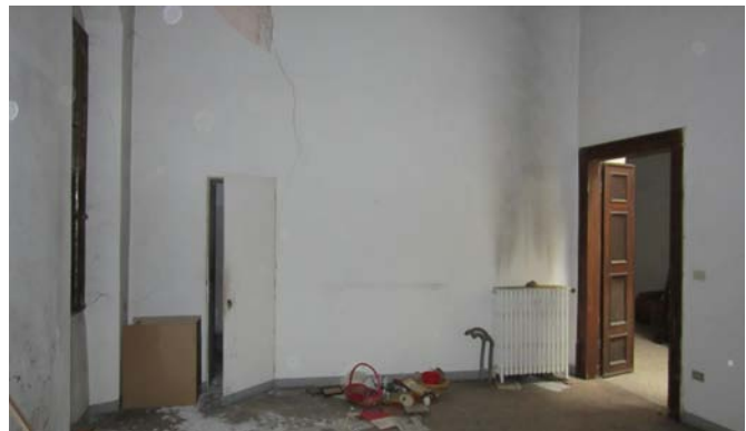
Fig.61 - Lato Ovest della stanza. Si notano le due aperture; quella a sinistra più piccola verso i servizi e l'altra verso il disimpegno del vano scale.
