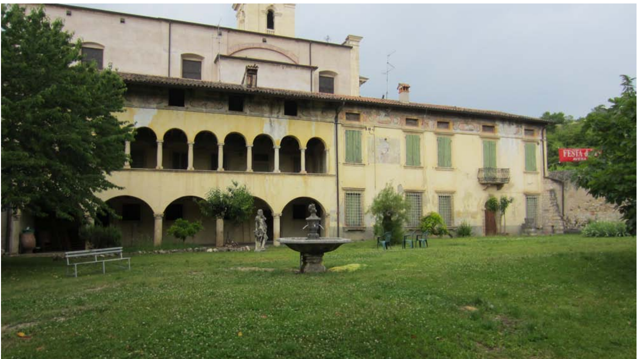
Fig.18 - Prospetto Sud del nucleo più antico di villa Rotàri-Cartolari; a sinistra il nucleo quattrocentesco con il loggiato sovrapposto al portico e a destra parte del fabbricato aggiunto durante i lavori di ampliamento avvenuti nel corso della prima metà del XIX secolo.
