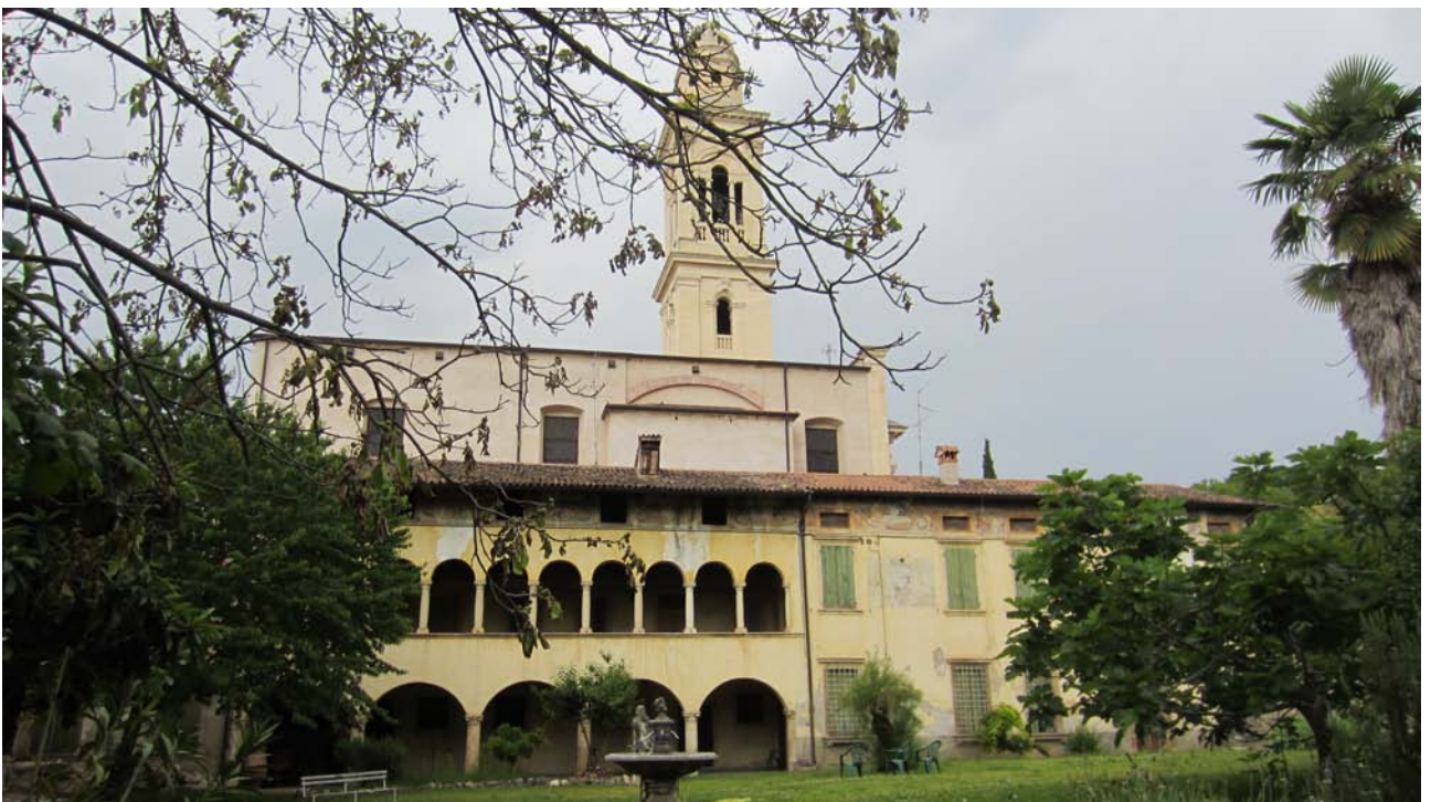
Fig.30 - Prospetto Sud di villa Rotari-Cartolari in Avesa. Appare facilmente leggibile la distinzione dei due edifici realizzati in epoche diverse: a sinistra il nucleo quattrocentesco caratterizzato dal binomio portico-loggia e, a destra, il corpo sette-ottocentesco con prospetto più regolare scandito dalla successione ritmica delle aperture e dalla presenza, in posizione centrale, del portone con apertura balconata sovrastante.
