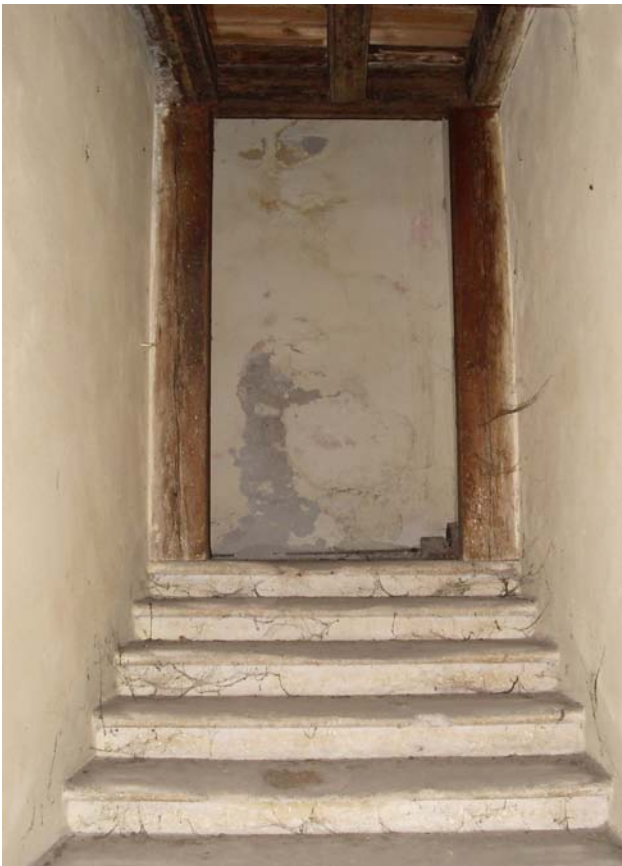
Fig.84 - Vista Nord della rampa ascendente.
