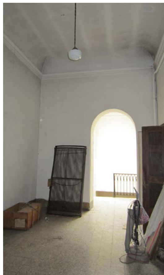
Fig.52 - Vista del lato opposto (Est) del disimpegno verso la rampa di scale incorniciata dal grande arco nella muratura.
