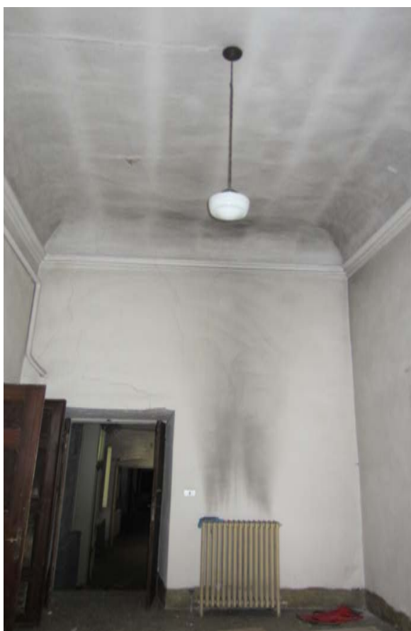
Fig.51 - Lato Ovest del disimpegno visto dalle scale. Da notare gli alti soffitti che saranno un elemento comune di questa ala ottocentesca.
