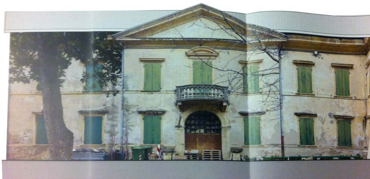
Fig.114 - Fotoraddrizzamento del prospetto Est dell'ala Ovest ottocentesca del complesso di villa Rotàri-Cartolari.
