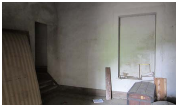
Fig.56 - Vista angolo Nord-Ovest del vano.
