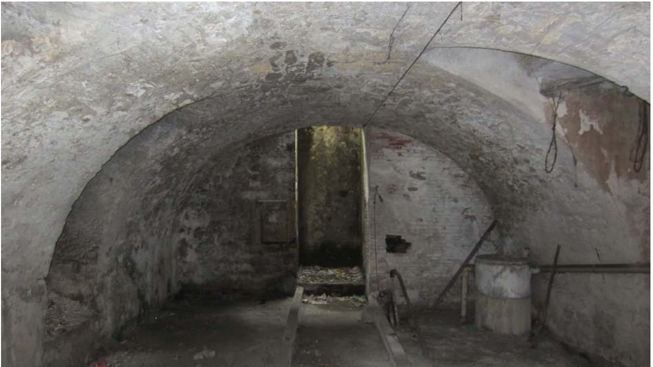
Fig.13 - Vista del piano interrato dalle scale verso Est. Di particolare interesse è l'imponente volta di copertura del locale.
