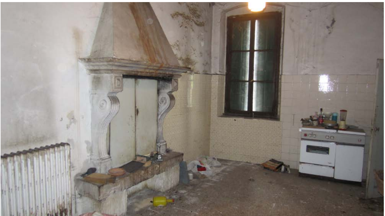
Fig. 25 - Vista dell'angolo Sud-Est della cucina. Elemento di pregio è senza dubbio il grande camino che si presenta con due volute che sorreggono la mensola modanata sulla quale s'impone la cappa.
