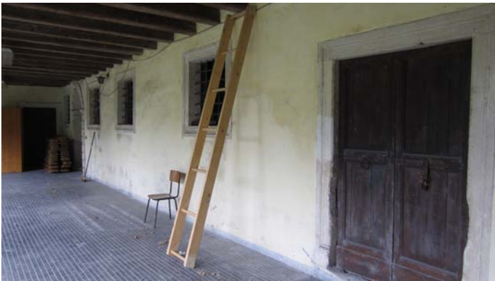
Fig. 32 - Prospetto Sud sotto il portico con finestre e porte impreziosite da una cornice modanata.
