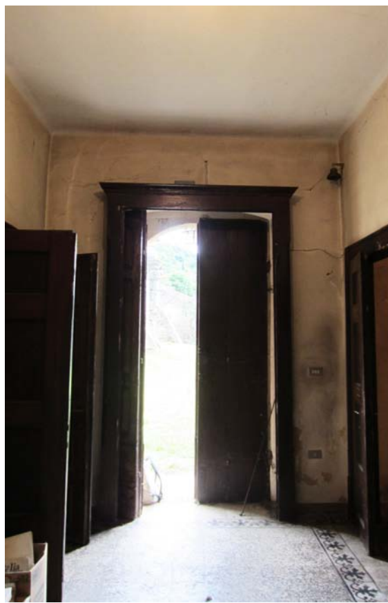
Fig.17 - Vista opposta del vano d'ingresso della villa verso il portale d'accesso principale posto sul lato Sud.
