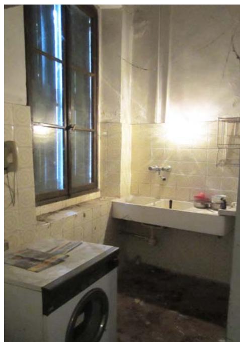
Fig.27 - Vista della piccola zona lavanderia.
