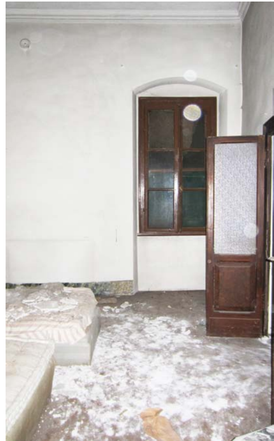
Fig.65 - Vista dell'angolo Sud-Ovest dove troviamo una grande apertura finestrata che si affaccia sul loggiato.
