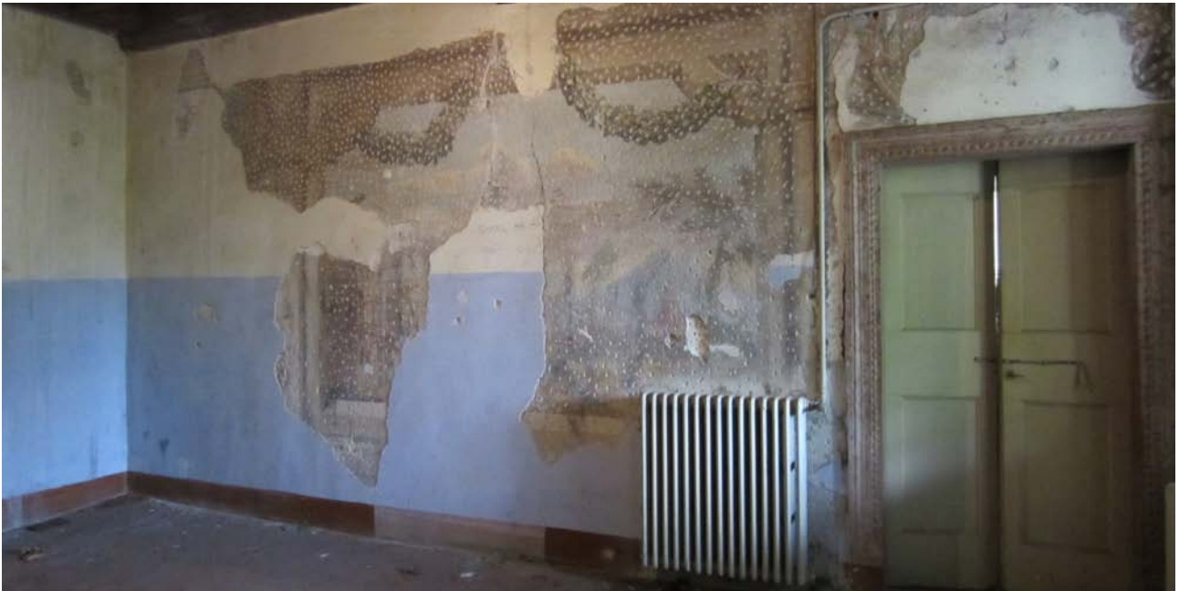
Fig. 80 - Parete Est del salone. Oltre la porta appena descritta troviamo un'interessante decorazione a tutta parete che rappresenta delle finte architetture che si aprono verso una serie di paesaggi. Queste decorazioni, insieme a quelle presenti nel salone adiacente, sono state picchiettate e intonacate dai soldati che occuparono la villa durante la Prima Guerra Mondiale.
