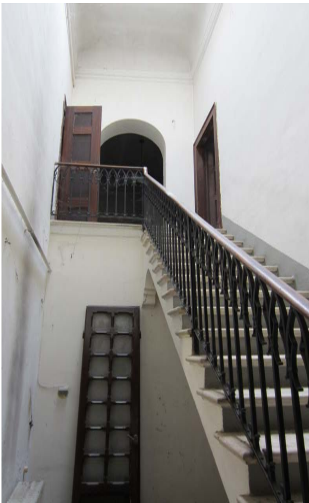
Fig.18 - Vano scala Est visto dal piano terra.
