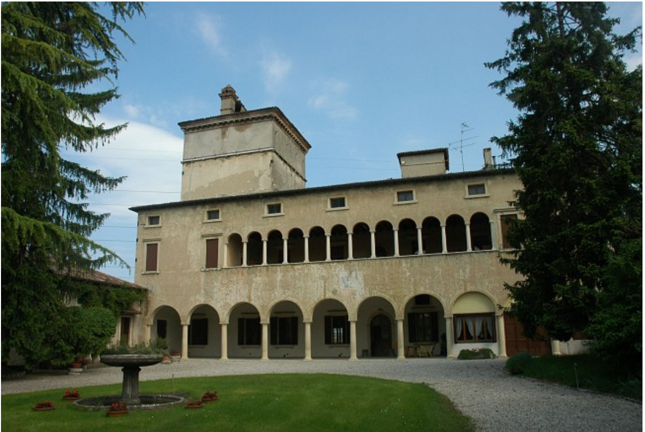
Fig.17 - Prospetto Sud di villa Ridolfi-Cossali con la caratteristica tipologia quattro-cinquecentesca a portico e loggia con affaccio verso la corte interna. Da notare a sinistra l'antica torre colombara appartenente al nucleo originario della villa e la fontana al centro del giardino che ricorda quella presente in villa Rotàri-Cartolari.
