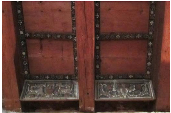
Fig.77 - Dettaglio delle decorazioni sugli elementi lignei che costituiscono il solaio.
