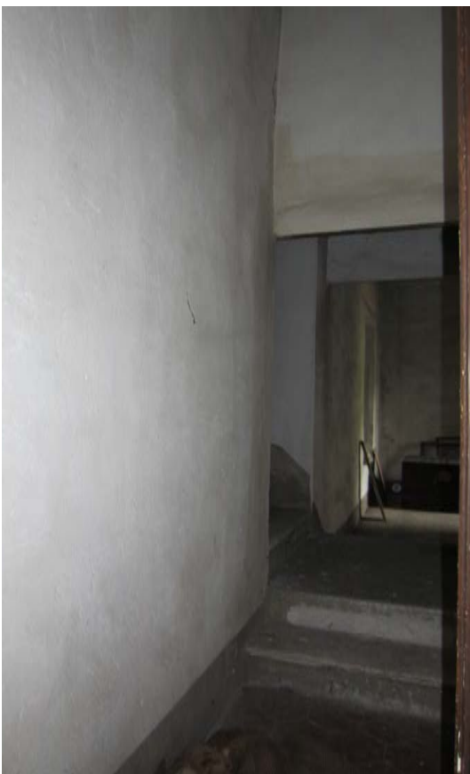
Fig.53 - Vista verso Est del corridoio che corre parallelamente al vano scala.
