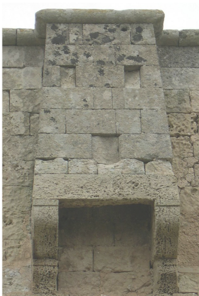
72. Particolare caditoia sopra l'ingresso principale
