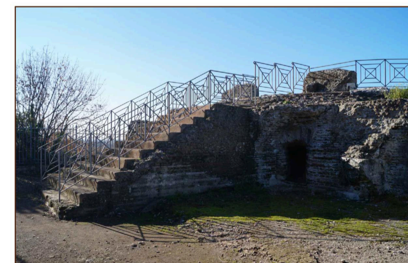
SCALA DI ACCESSO AL PIANO SUPERIORE DELLA ROCCA
