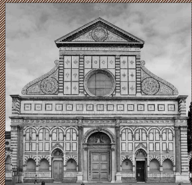
FACCIATA DELLA CHIESA DI SANTA MARIA NOVELLA LEON BATTISTA ALBERTI FIRENZE
