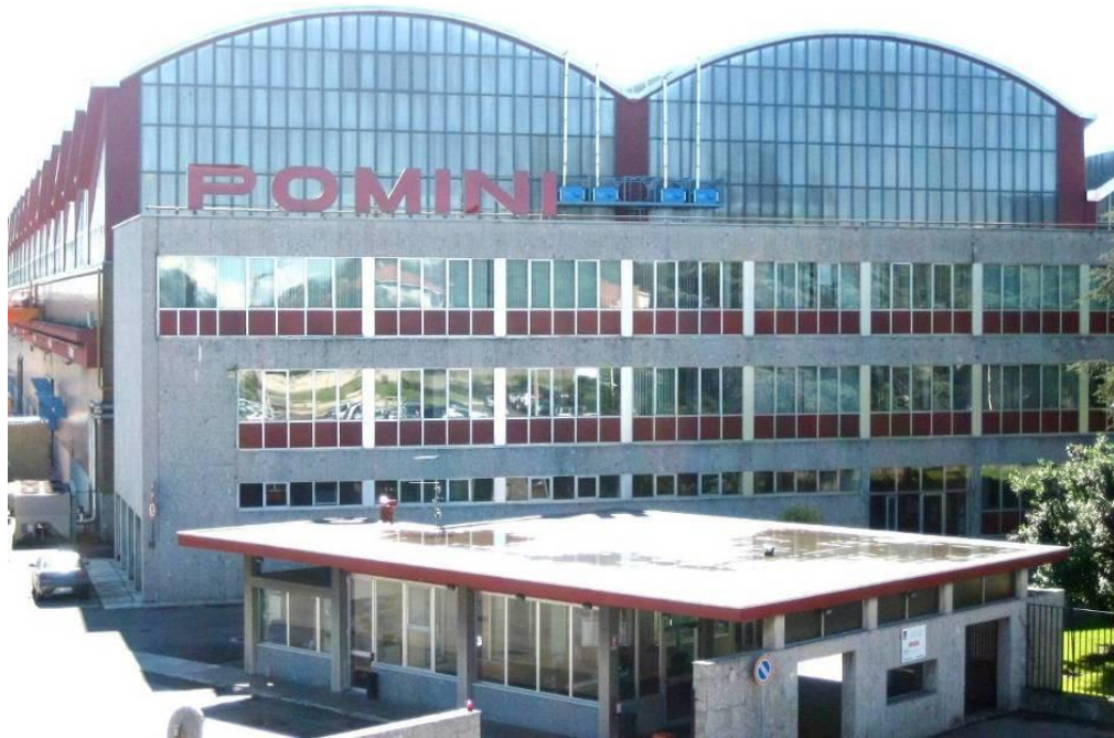
Figura 1.1 Vista esterna Pomini-Tenova S.p.a.
