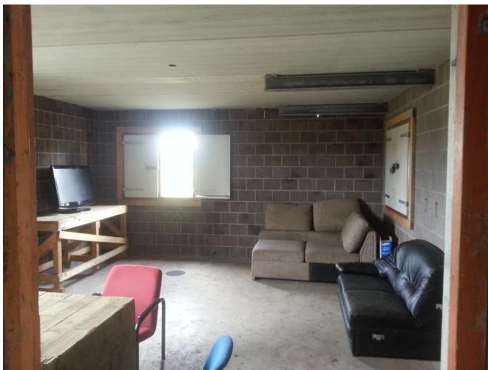
Figura 2.15.2. Foto interna dell'edificio da ispezionare per la prova C.
