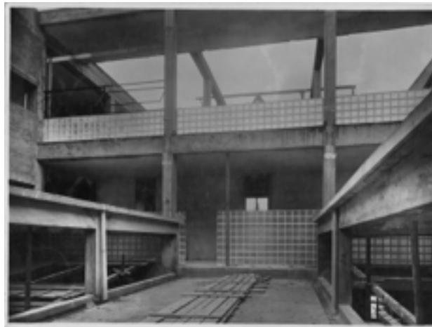
fig. 4.40 Veduta del cantiere durante la realizzazione dei vetrocementi della corte centrale.
