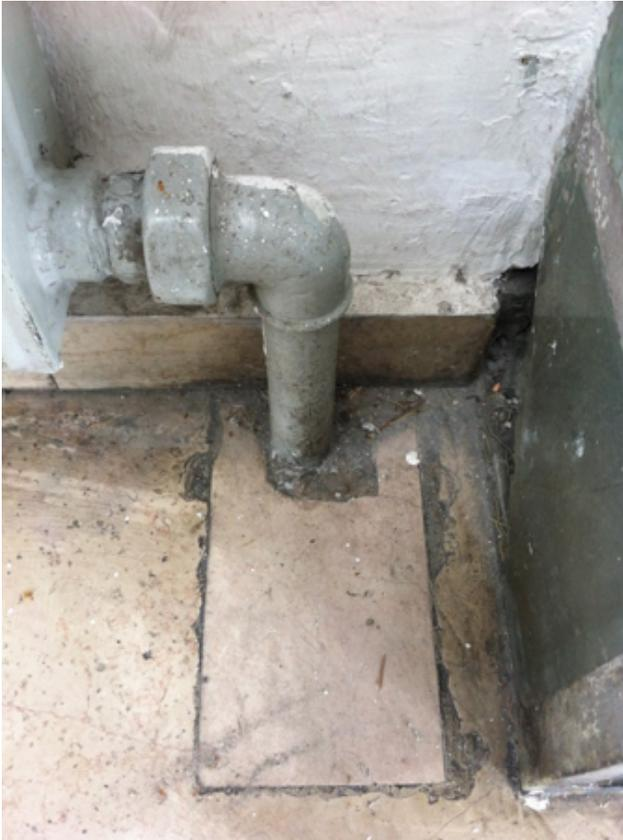
fig.6.6 – Particolare generale n°1 di un attacco a terra dei caloriferi installati nell'atrio principale a piano terra, si nota il cambio di pavimentazione in luogo dell'originale, a conferma dell'avvenuta installazione dei caloriferi a posteriori rispetto alla realizzazione del manto finale di piastrelle a piano terra.
