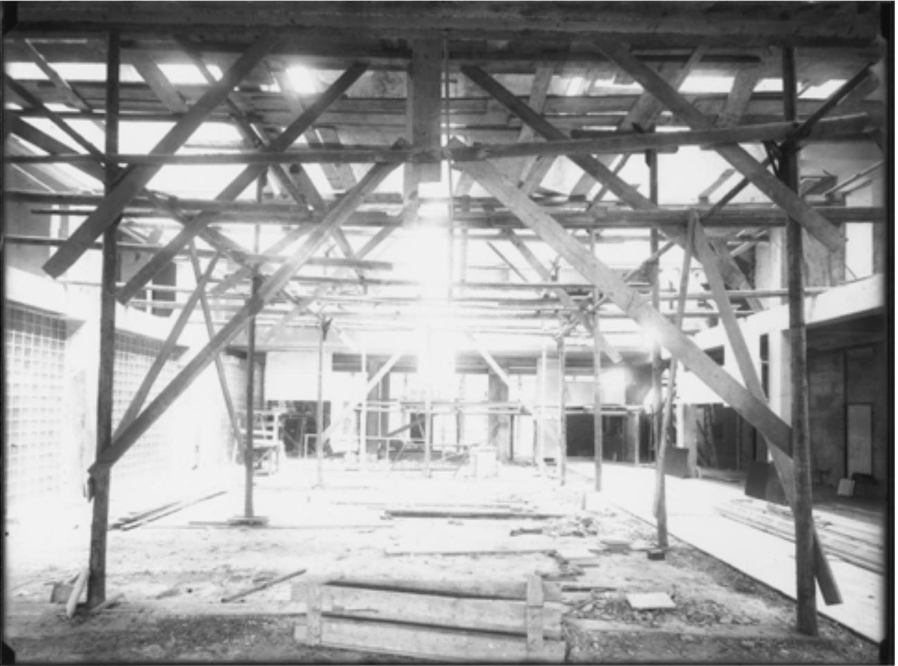
Fig 4.36. Veduta del cantiere durante la realizzazione della copertura dell'atrio in vetrocemento.
