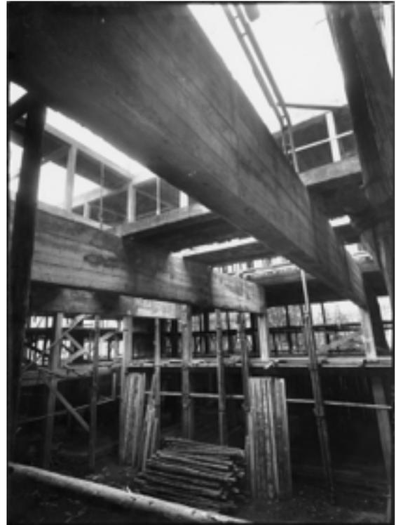
Fig 4.27. Veduta del cantiere durante la realizzazione di pilastri e travi.
