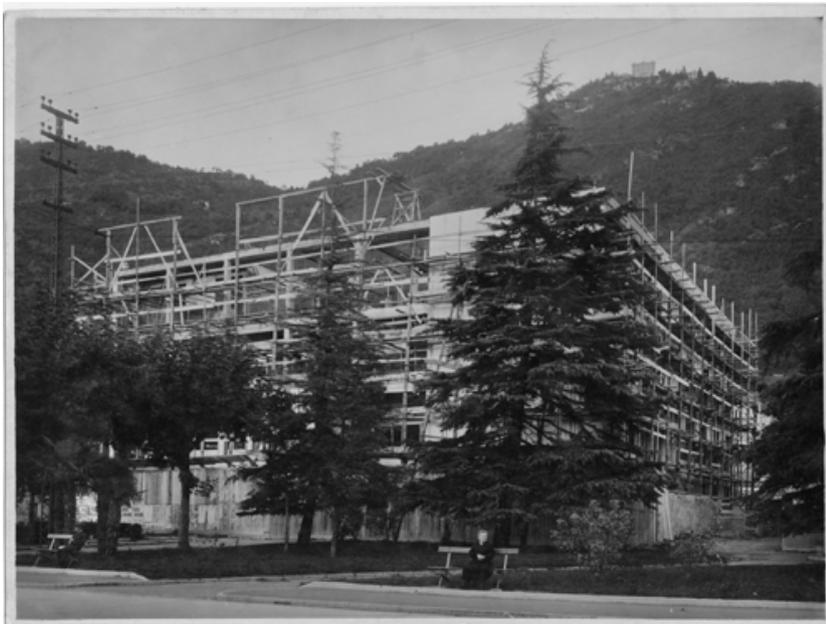
fig. 5.18 – Foto storica di cantiere dove si denota la presenza del ponteggio e la Casa del Fascio in costruzione. Importante notare la diversa conformazione di Piazza del popolo e la presenza su tutta la piazza, di vegetazione ad alto fusto.
