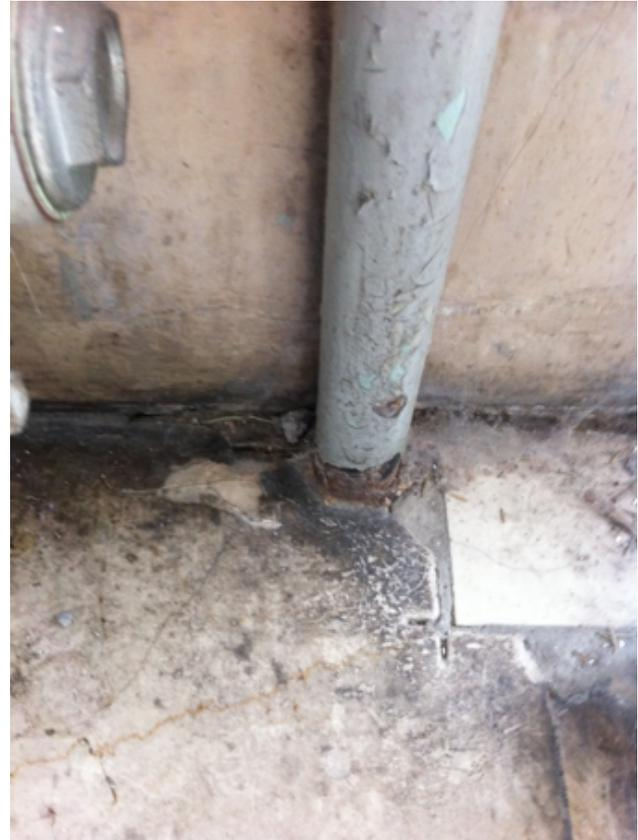
fig.6.7 - Particolare generale n°2 di un attacco a terra dei caloriferi installati nell'atrio principale a piano terra, si nota il cambio di pavimentazione in luogo dell'originale, con incisioni da strumento da taglio sulla piastrella originale, a conferma dell'avvenuta installazione dei caloriferi a posteriori rispetto alla realizzazione del manto finale di piastrelle a piano terra.
