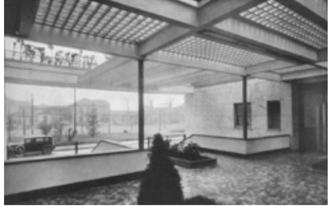
fig. 2.36. Veduta dell'ingresso con la copertura in vetrocemento
