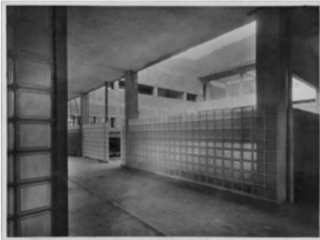
fig. 4.41. Veduta del cantiere durante la realizzazione dei vetrocementi della corte centrale.
