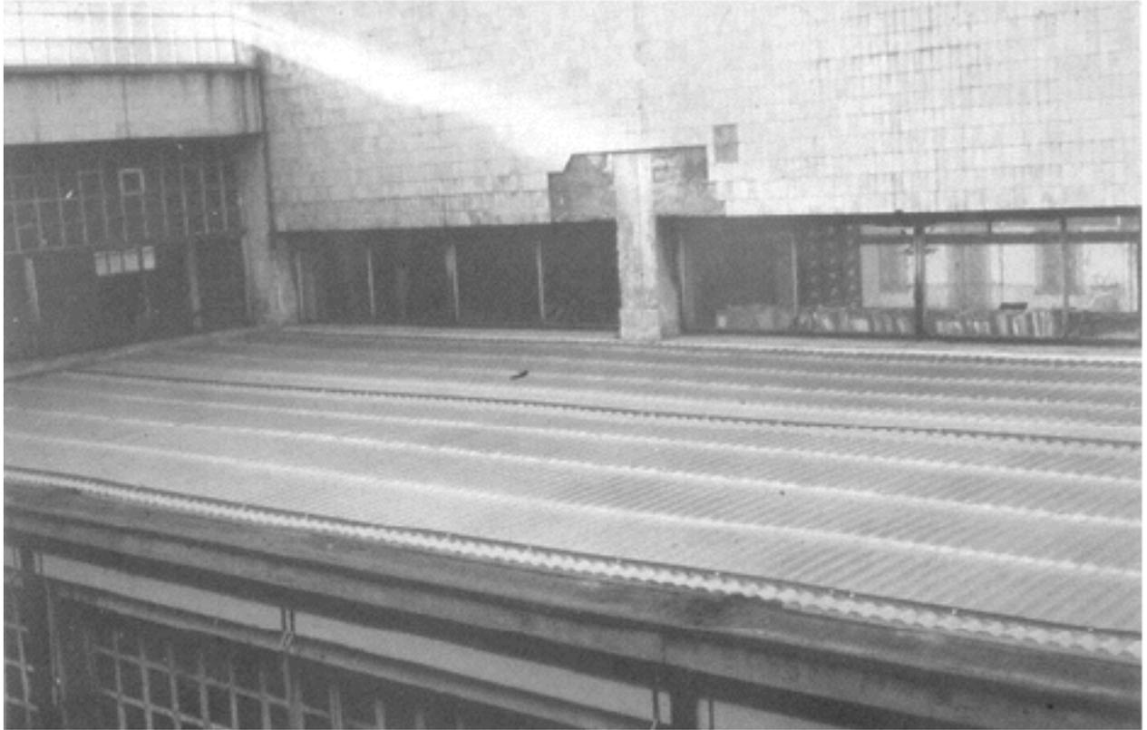
fig. 4.49 Copertura in ondolux posizionata prima del restauro della copertura in vetrocemento a cura di A. Artioli
