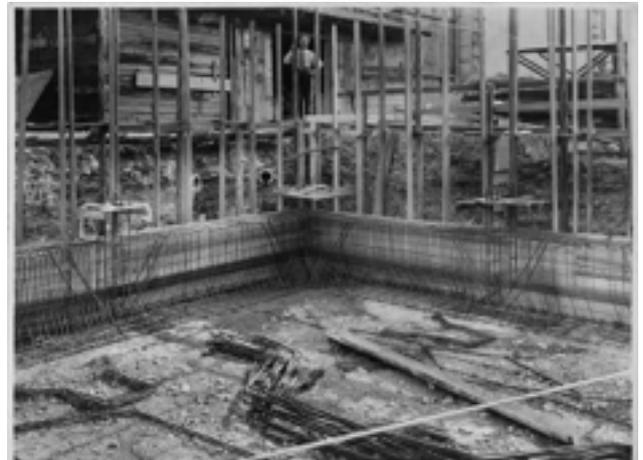
Fig 4.20. Veduta del cantiere durante la realizzazione delle fondazioni. Si possono notare i ferri delle armature di cui esiste un elaborato grafico tecnico.
