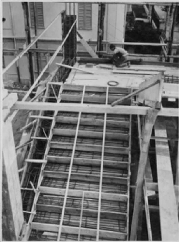
Fig 4.33. Veduta del cantiere durante la realizzazione delle scale. Si notano i casseri per la gettata di calcestruzzo.
