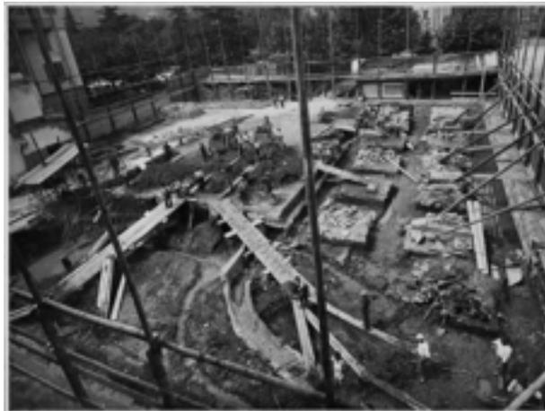
Fig 4.14. Veduta del cantiere durante la realizzazione delle fondazioni. Dalla foto si può notare il quantitativo d'acqua presente nel terreno durante gli scavi.
