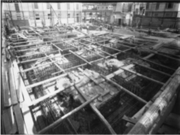
Fig 4.17. Veduta del cantiere durante la realizzazione delle fondazioni. Posa in opera delle armature delle travi.
