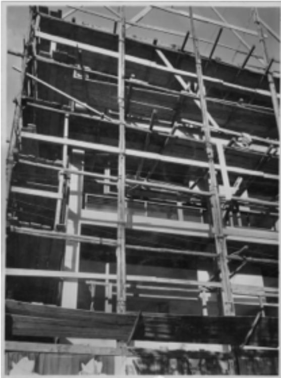
Fig 4.26. Veduta del cantiere durante la realizzazione di pilastri e travi.
