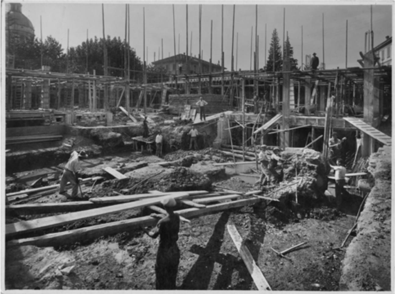
Fig 4.16. Veduta del cantiere durante la realizzazione delle fondazioni. Dalla foto si possono intravedere i primi pilastri poggiati sulla struttura reticolare e la gettata del pavimento del piano cantinato rialzato con muretti in mattoni.
