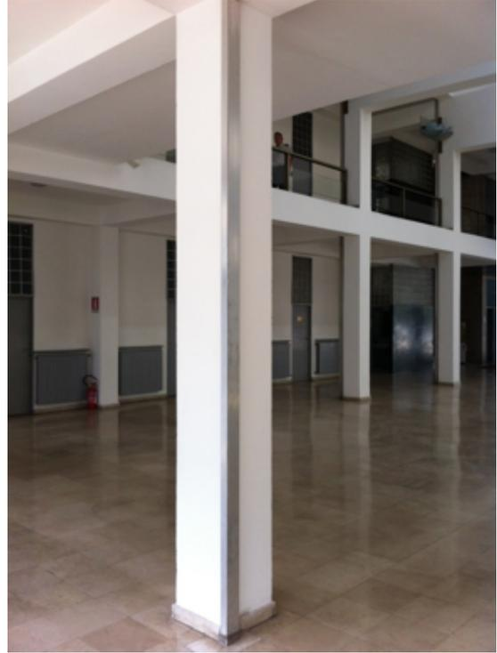
fig.6.3 – Fotografia odierna (anno 2015) rappresentante la situazione attuale in merito alla presenza dei radiatori caloriferi (come è visibile, i radiatori scaldanti sono stati aggiunti in prossimità delle murature perimetrali interne) che di seguito nell'elaborato verranno quantificati e catalogati in base alla loro disposizione planimetrica e conformazione.
