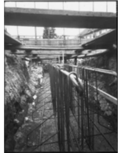
Fig 4.25. Veduta del cantiere durante la realizzazione dei pilastri.
