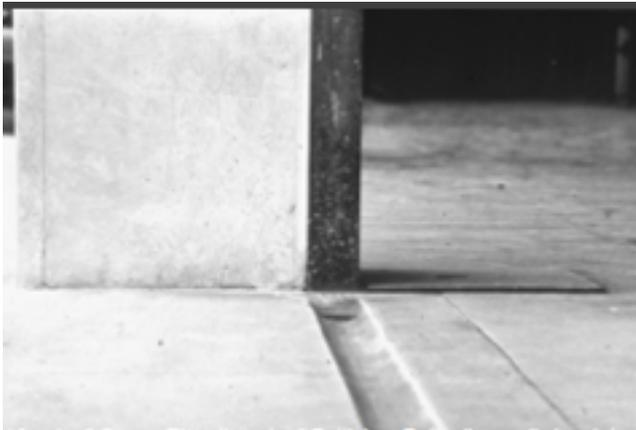
**fig. 4.45** Dettaglio delle lastre di calcare di Botticino sulle balconate della loggia. Particolare della canalina per la raccolta delle acque.
