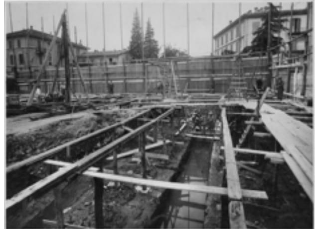
Fig 4.18. Veduta del cantiere durante la realizzazione delle fondazioni.
